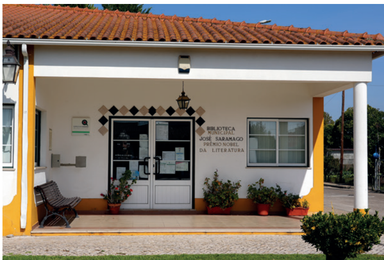
Fig. 8– Biblioteca Municipal José Saramago, na Azinhaga (Fonte: Autores, 2023).
