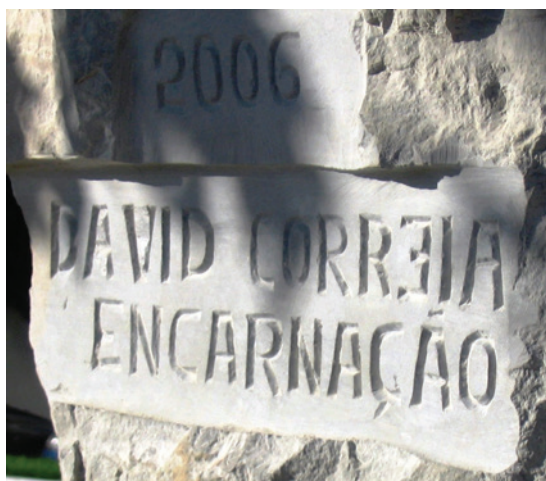
Fig. 11 – Erro de posição do canteiro.
