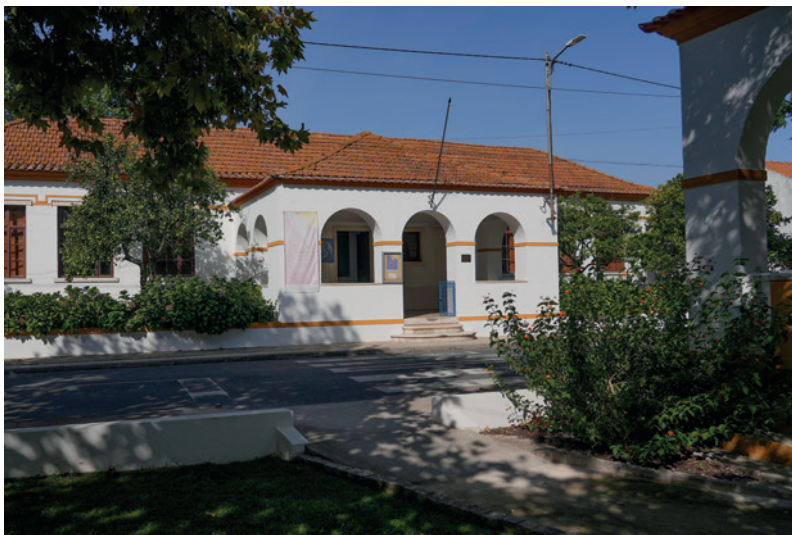
Fig. 10 – Delegação da Fundação José Saramago, na Azinhaga (Fonte: Autores, 2023).
