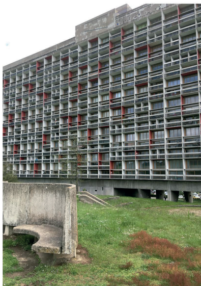
FOTO 1 - Unidade de Habitação de Firminy, de Le Corbusier (Fonte: Fotografia do Autor, 2019).
