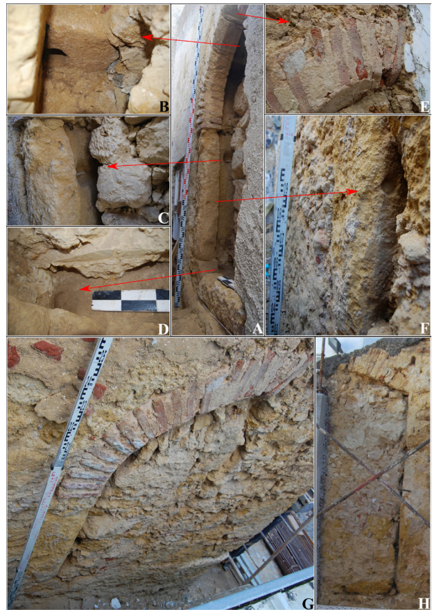
Fig. 7 - A e G: Porta de arco quebrado no lado Este do edifício; B, C, D, E e F: Pormenores da porta de arco quebrado; H: Porta de arco quebrado, vista do interior do edifício.
