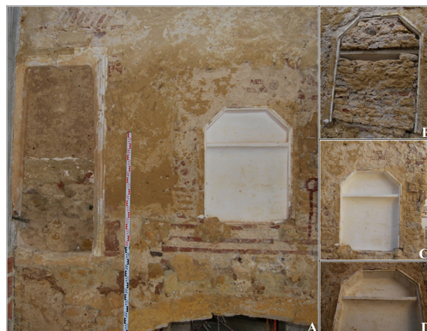
Fig. 4 - A: Porta/passagem e armário de parede na sala 5 (1.º andar); B, C e D: Pormenores do armário de parede na sala 5 (1.º andar).
