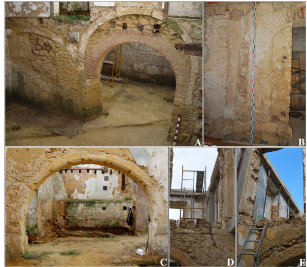
Fig. 2 - A: Sequência de arcos entre as salas 1 e 2; B: Portas das salas 1 e 2 (1.º andar); C: Arco entre as salas 5 e 6; D e E: Porta entre as salas 5 e 6 (1.º andar).
