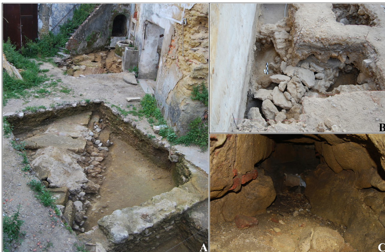
Fig. 9 - A e B: Grande canalização; C: Bifurcação da grande canalização sob as escadas.
