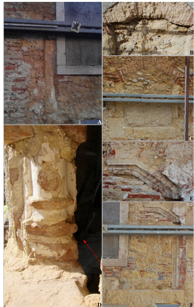
Fig. 6 - Janelas entaipadas na fachada: A: Janela de sacada; B: Pormenor da verga, em formato de trapézio, de janela chanfrada; C: Janela chanfrada; D: Colunelo da janela chanfrada; E: Verga, em formato de trapézio, de janela moldurada; F: Janela moldurada.
