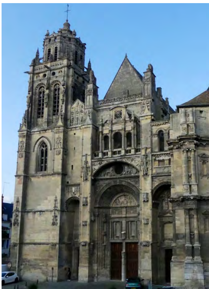
Fig. 18 - Façade occidentale de l'église Saint-Gervais-Saint-Protais de Gisors
