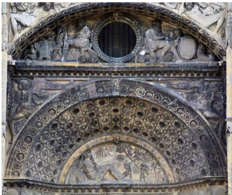
Fig. 19 - Détail des voûtes et des tympanes de la façade occidentale de l'église Saint-Gervais-Saint-Protais de Gisors.
