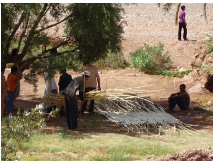
Fig. 7. Construcción de la techumbre (créditos: autora).
