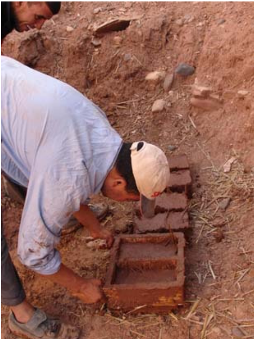
Fig. 4. Ejecución de ladrillos de adobe (créditos: autora).
