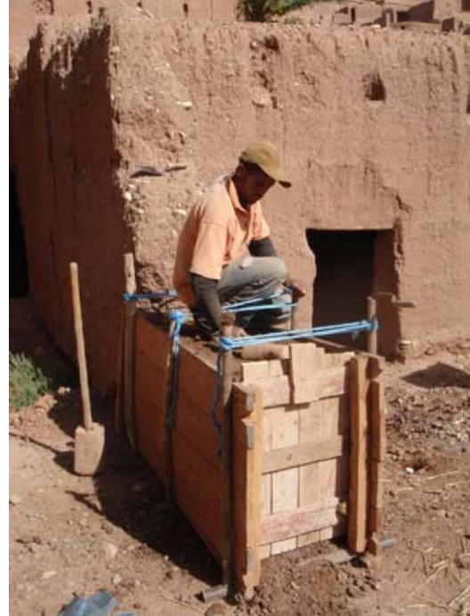
Fig. 3. Construcción de tapial (créditos: autora).
