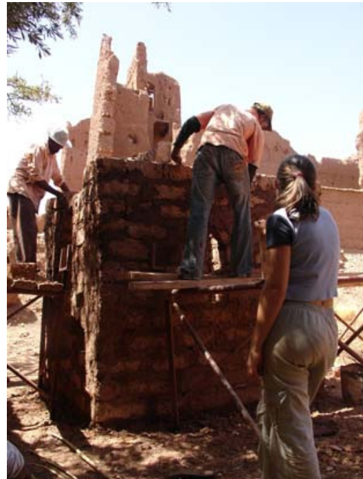
Fig. 5. Levantamiento del muro (créditos: autora).
