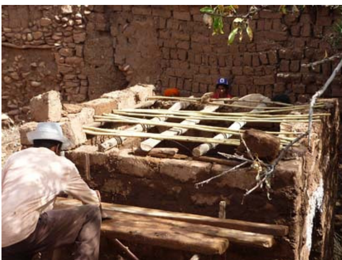
Fig. 8. Preparación de la cubierta (créditos: autora).
