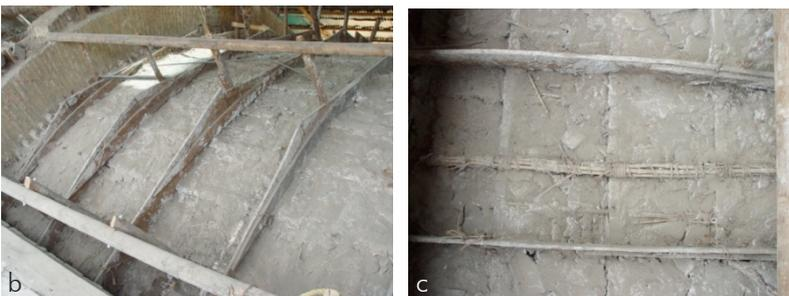
Fig. 5. (a) Elementos que conforman la bóveda de bahareque; (b) y (c) Imágenes de la bóveda de bahareque
