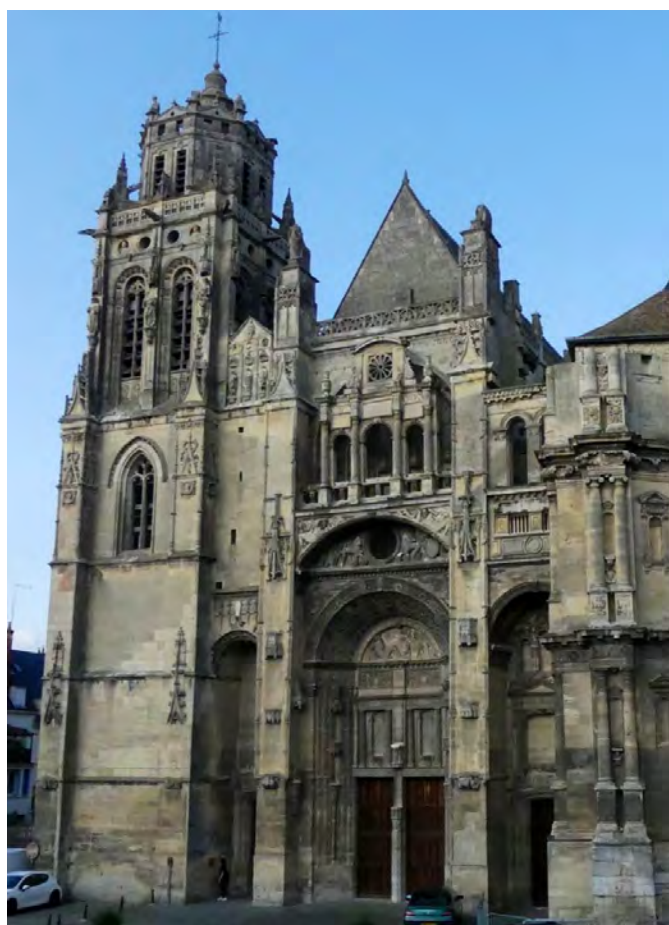
Fig. 18 - Façade occidentale de l'église Saint-Gervais-Saint-Protais de Gisors
