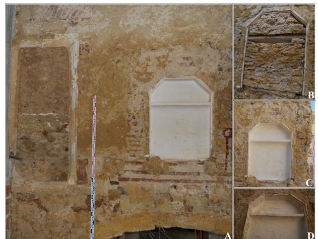
Fig. 4 - A: Porta/passagem e armário de parede na sala 5 (1.º andar); B, C e D: Pormenores do armário de parede na sala 5 (1.º andar).
