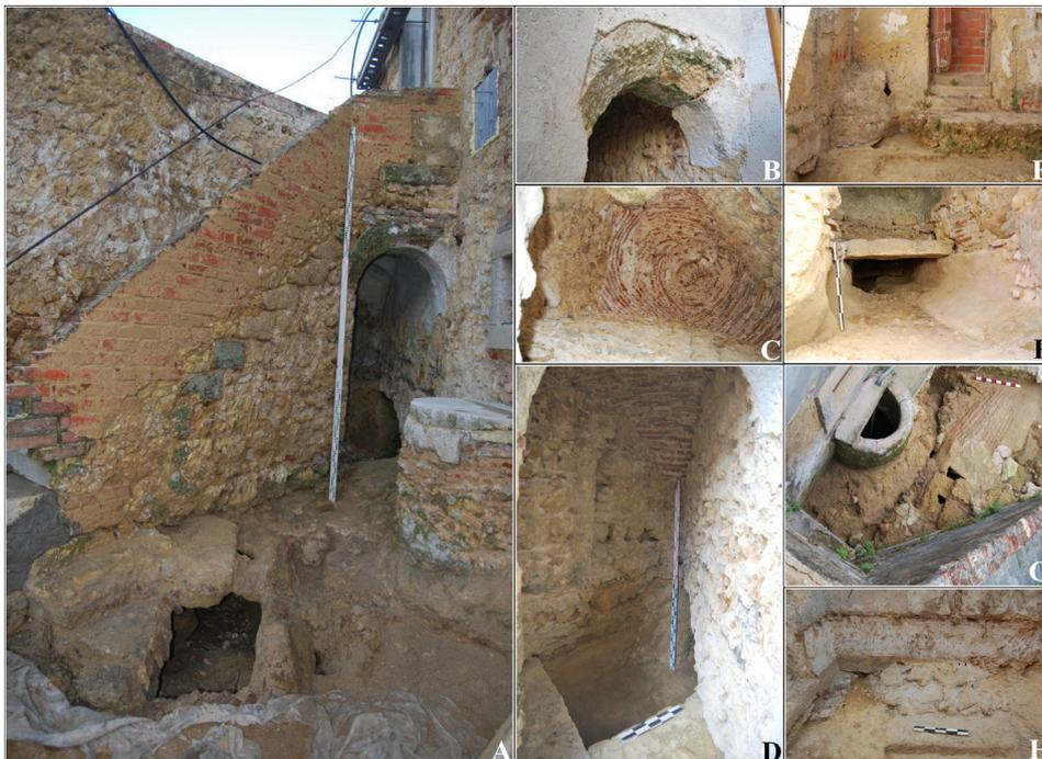
Fig. 8 - A: Escadas e arco chanfrado, na passagem para espaço abobadado sobre grande canalização; B, C, D e F: Pormenores do espaço abobadado e grande canalização sob as escadas; E: Abóbada da grande canalização no canto da sala 5; G: Poço e grande canalização; H: Poço no interior da sala 5.
