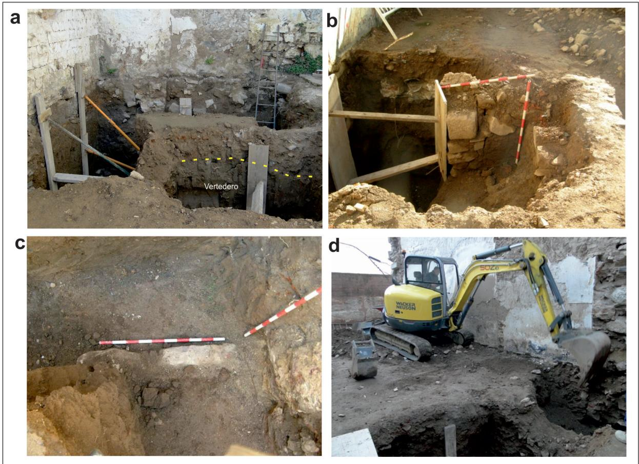
Fig. 2 - Vista parcial de las zonas intervenidas previamente en el solar antes de comenzar nuestro trabajo (a. Zona Zapata 1; b. Zapata 3; c. Detalle muro localizado en zapata 1; d. inicio de nuestro seguimiento con la ejecución de las riostras que unían las zapatas).
