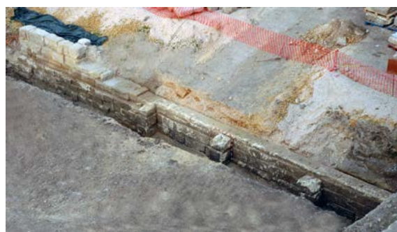
Figura 5. Muro occidental del períbolos (Sergio García-Dils).
