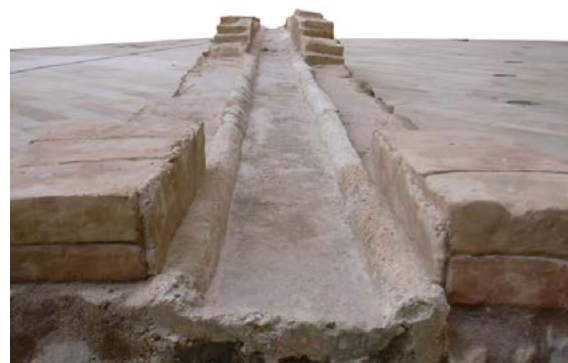
Figura 18. Detalle del canalis structulis y specus localizado en la Plaza Ivonne Cazenave.
