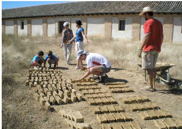
Fig. 4. Varias generaciones tendiendo adobes para la bóveda a orillas del canal de Castilla (créditos: ESTEPA, 2009)
