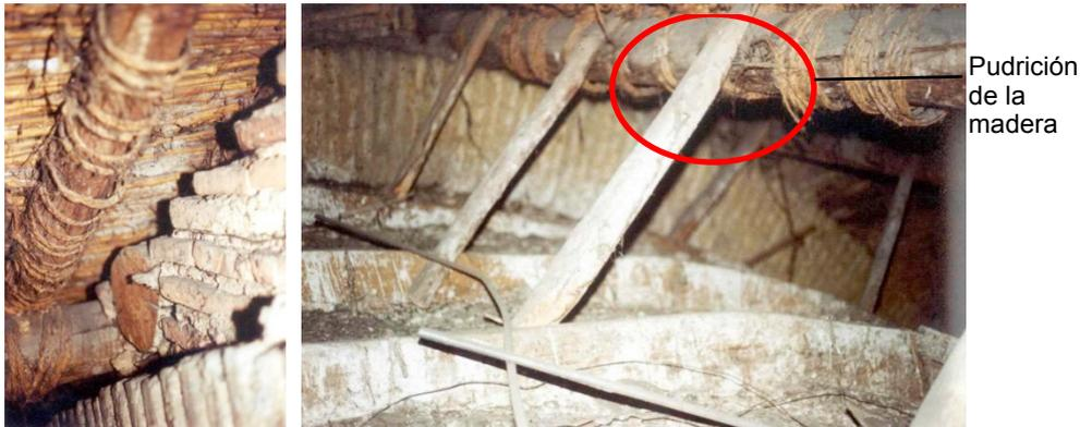
Fig. 6. (a) deterioro de los amarres y (b) pudrición de las vigas
