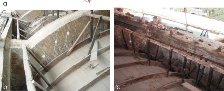
Fig. 4. (a) Elementos que forman la bóveda de madera; (b) y (c) Imágenes de la bóveda en madera
