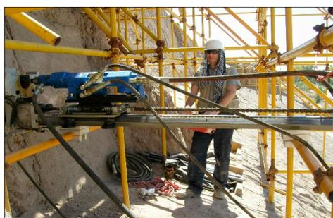
Fig. 6. Andamio, perforación y colocación de varillas de fibra de vidrio en posición. Ciudadela de Bam, Irán (Crédito: Ing. Valter Santoro, 2008).
