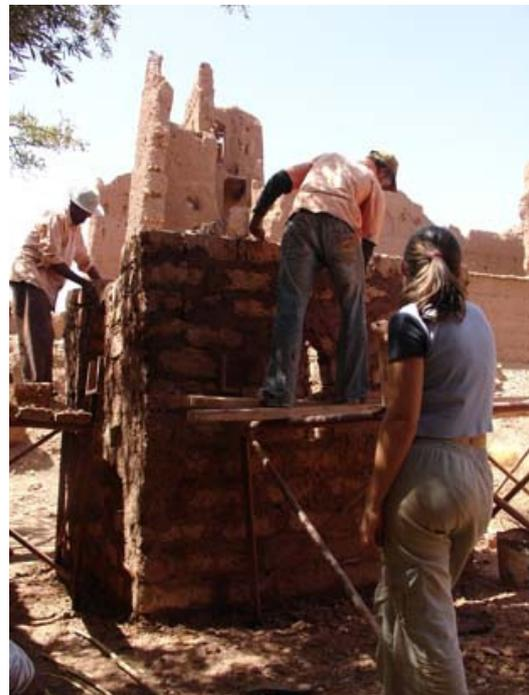
Fig. 5. Levantamiento del muro (créditos: autora).
