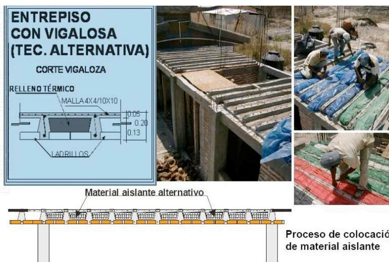
Fig. 3. Esquema da laje leve mexicana que emprega como enchimento leve casca de coco, serragem, ou resíduo de PET. Protótipo instalado no campus da Universidad Autónoma de Chiapas, México (Crédito: Gabriel Castañeda, 2008)
