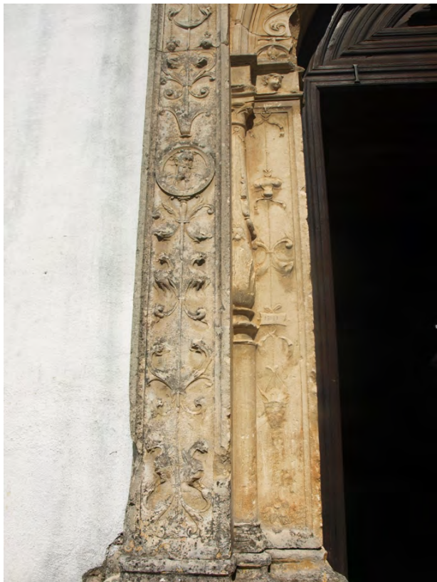
Fig. 5 - Sardoal, Igreja da Misericórdia, portal, coluna adossada.
