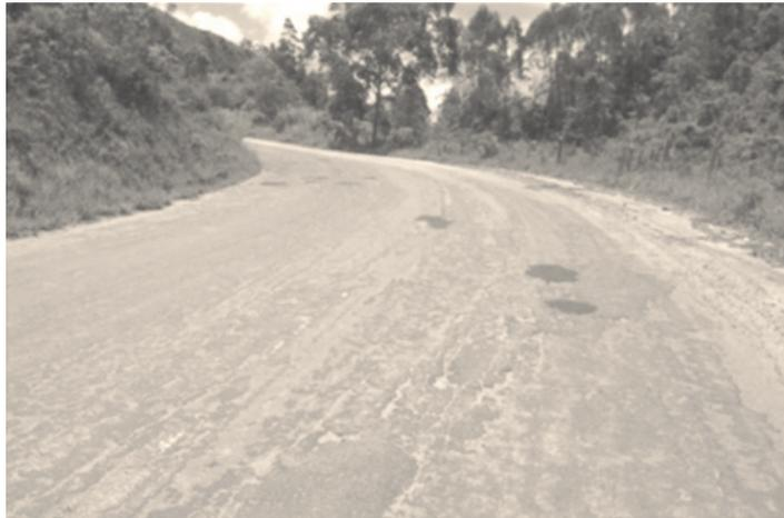
**Fig. 1** – Estado de conservação da rodovia da RJ-148 construída em 1979 com base de solo-emulsão (Thuller, 2005).
