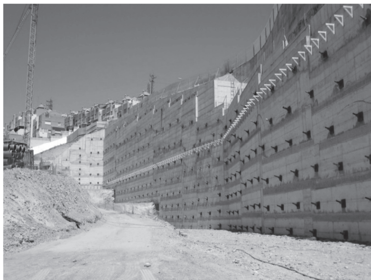
Fig. 5 – Pantalla de micropilotes con todos los niveles de anclajes ejecutados
