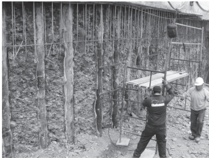
Fig. 2 – Aspecto de la pantalla de micropilotes en un tramo en que se limpió el terreno para construir el forro exterior
