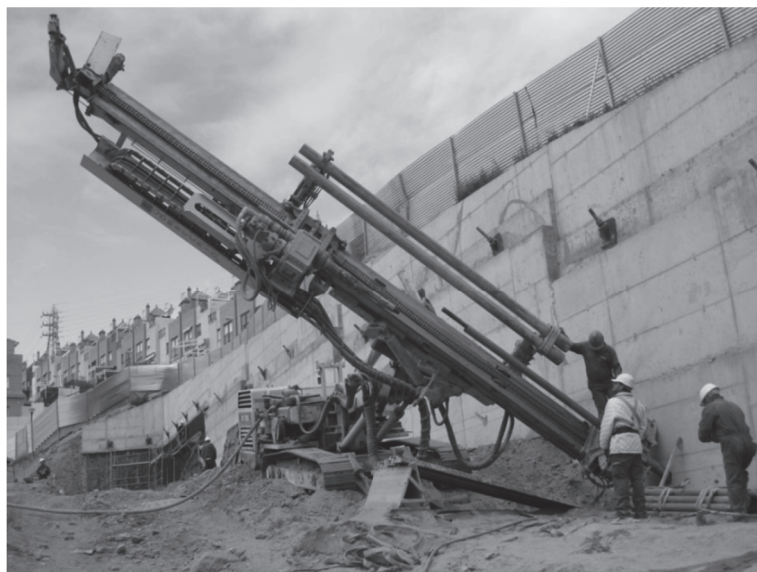
Fig. 4 – Máquina perforando el taladro para instalar un anclaje
