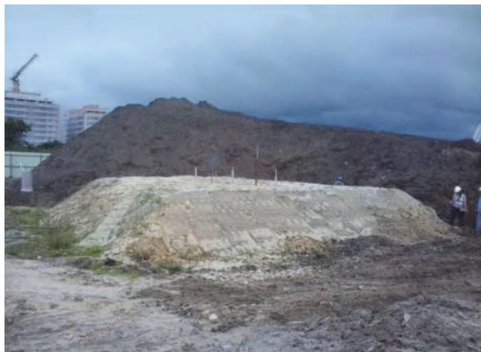
**Fig. 19** – Material de descarte depositado próximo ao aterro teste sem tratamento
