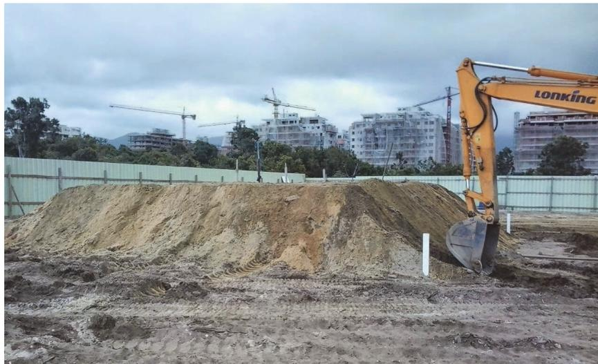
Fig. 14. Aterro teste finalizado, com os instrumentos instalados
