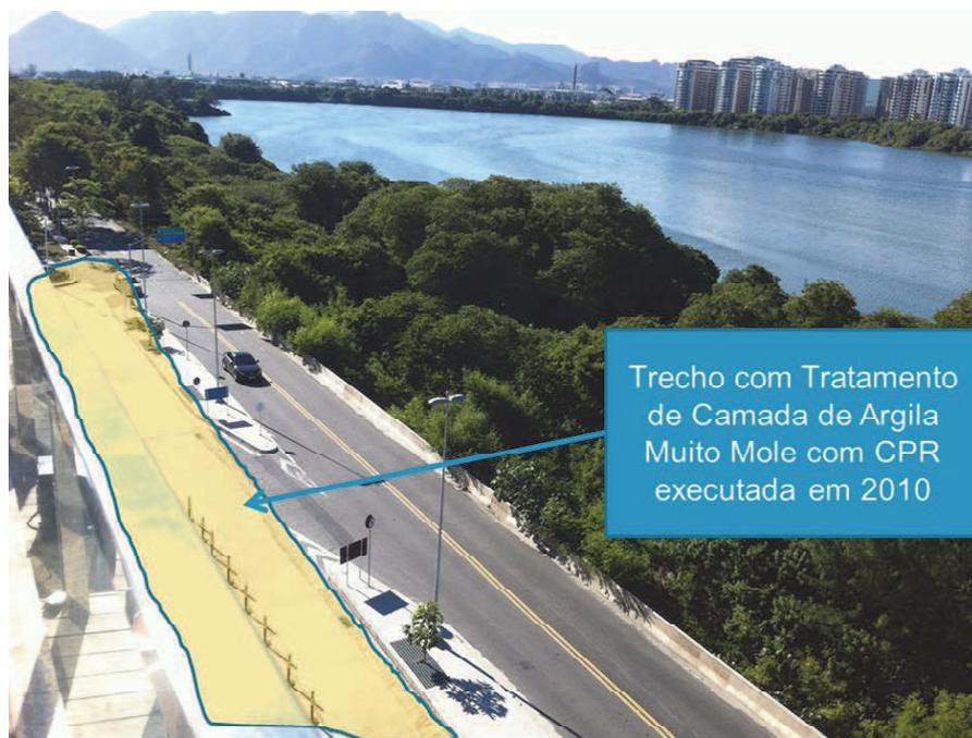
**Fig. 2** – Área de tratamento de solo mole em trecho da Via de Acesso (Geoinfra, 2010)
