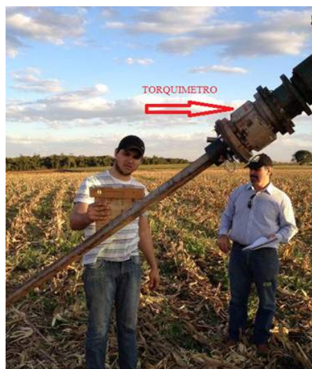
Fig. 4 – Procedimento de instalação da estaca helicoidal
