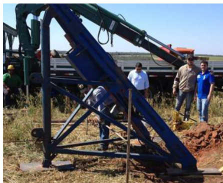
Fig. 5 – Tripé para aplicação das cargas axiais da estaca
