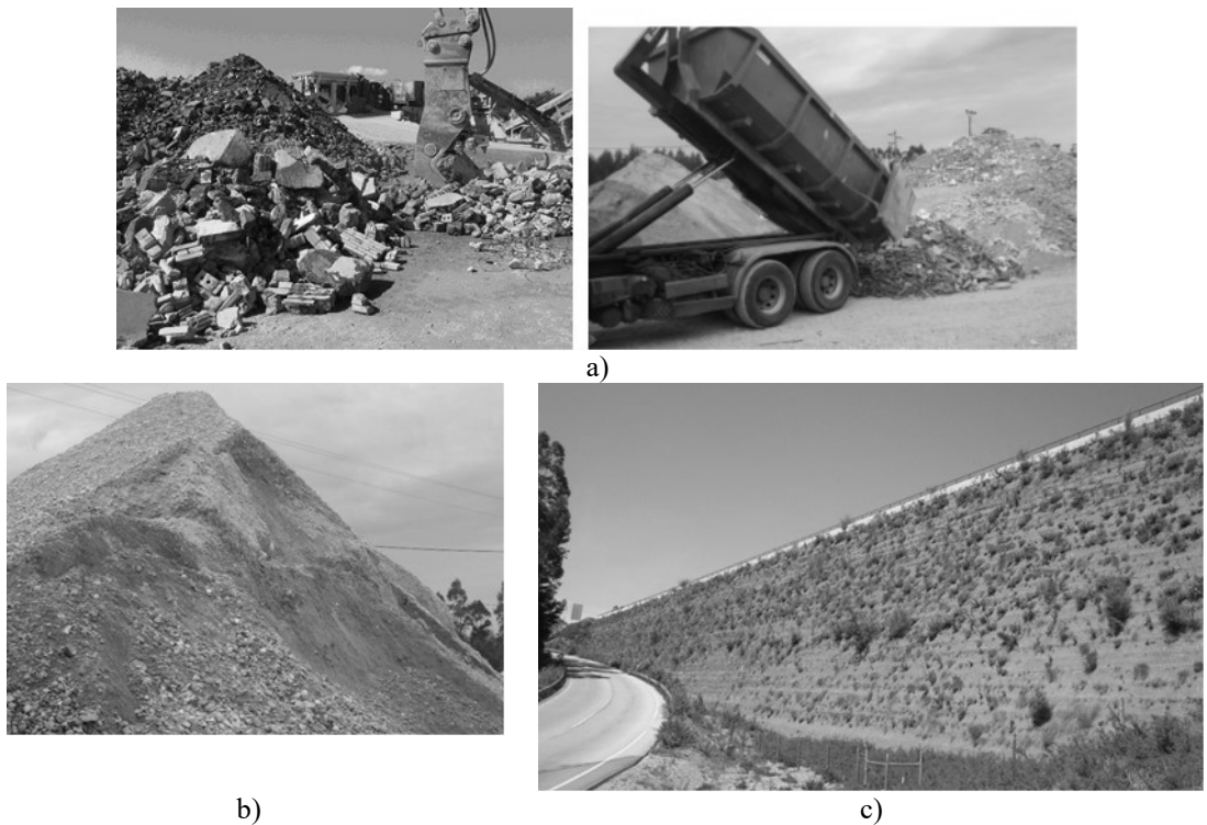
Fig. 33 – a) Resíduos de Construção e Demolição; b) agregado reciclado; c) aterro reforçado com geossintéticos.
