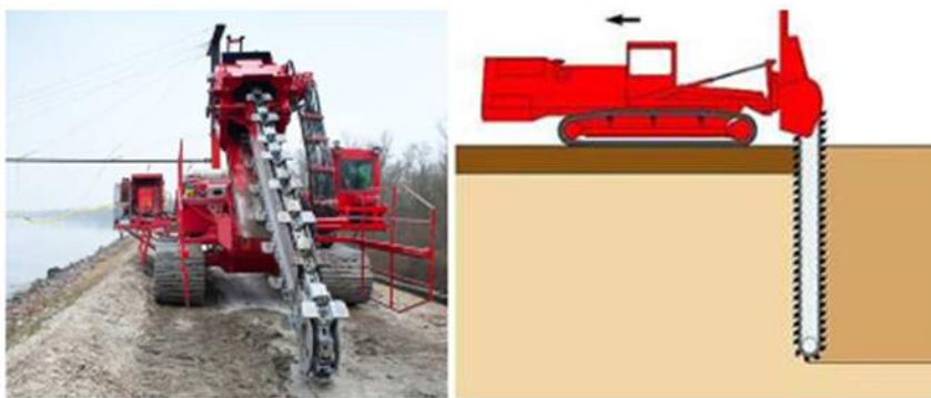
Fig. 9 – Esquerda: Equipamento de Trenchmix; Direita: Esquema de execução (Soletanche-Bachy).
