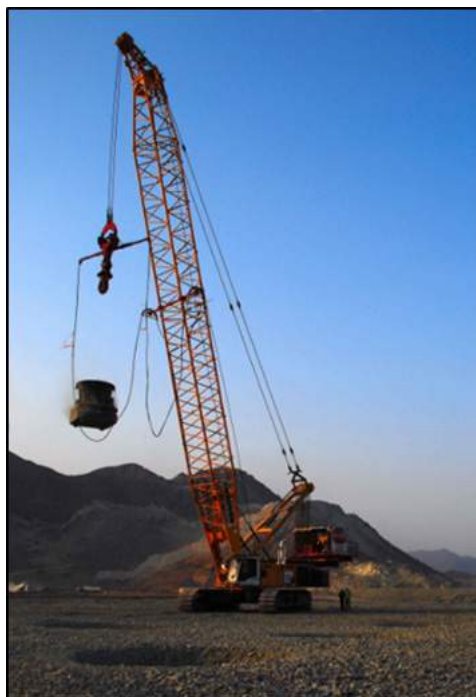
Fig. 4 – Sistema MARS / Compactação Dinâmica de Alta Energia (Menard).
