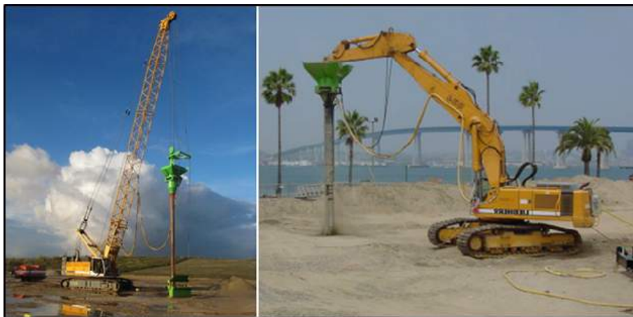
Fig. 7 – Esquerda: “VREX System”, Direita: “DBF Stitcher” (Menard).
