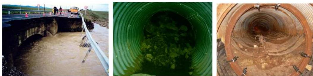
Fig. 25 - Defeitos observáveis no sistema de drenagem.
