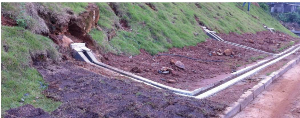
**Fig. 11** – DHPs e canaletas para escoamento da água.
