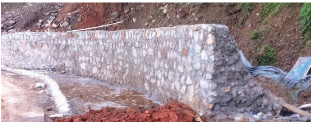
**Fig. 10** – Muro de pedra argamassada.
