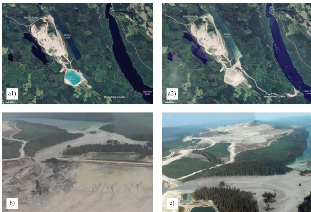
Fig. 12 – Rotura da barragem de rejeitados da mina Mount Polley (Canadá), em 4/8/2014. As fotos das figuras a) foram tomadas da mesma posição, antes e depois do acidente.
