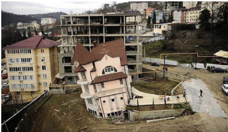
Fig. 7 – O colapso da frente de um túnel, ocorrido em março de 2013, em Sochi, provocou um grande assentamento do prédio à superfície.
