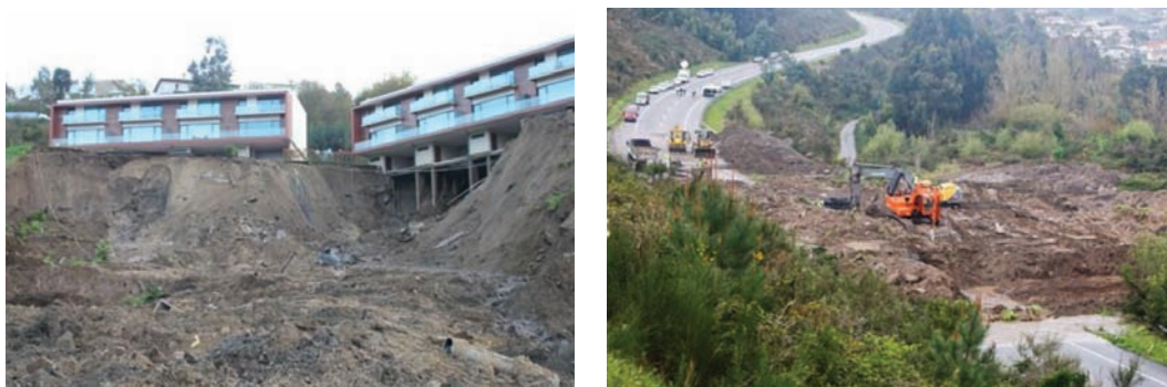
Fig. 10 – Aspectos do escorregamento ocorrido em abril de 2013, perto de Guimarães.
