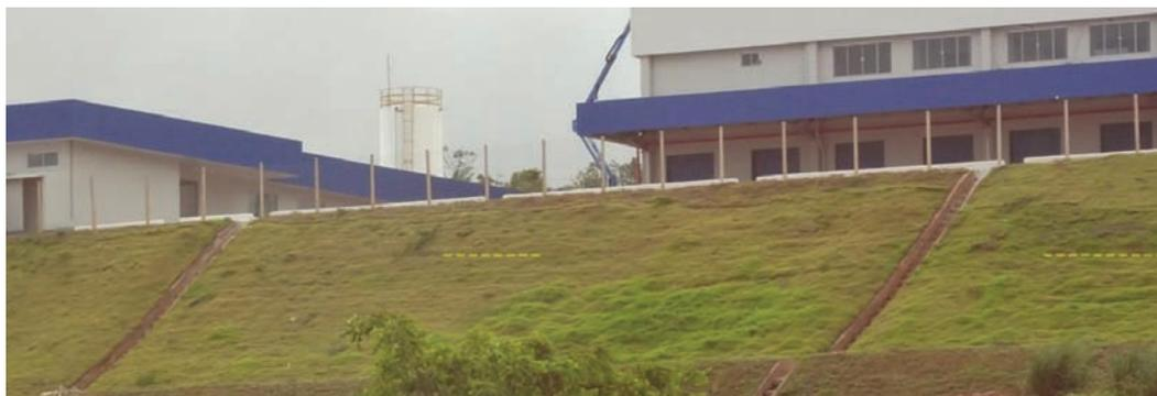
Fig. 2 – Na parte inferior da foto é observável deslizamento de solo na Formação Cabo (Kc).
