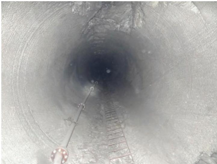
Fig. 2 – Quebras diametralmente oposta em poços de ventilação.
