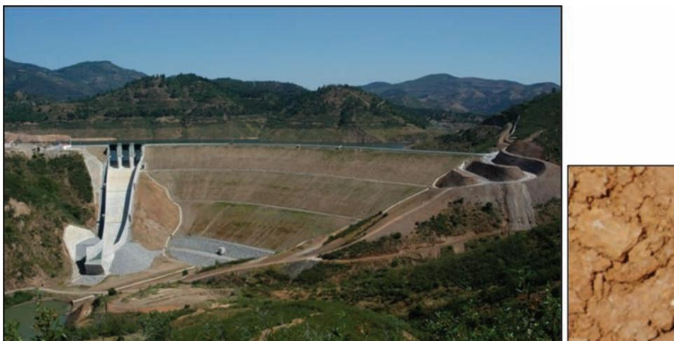
**Fig. 15** – Fotografia da Barragem de Odelouca vista de jusante e do material argiloso usado para a construção do núcleo.
