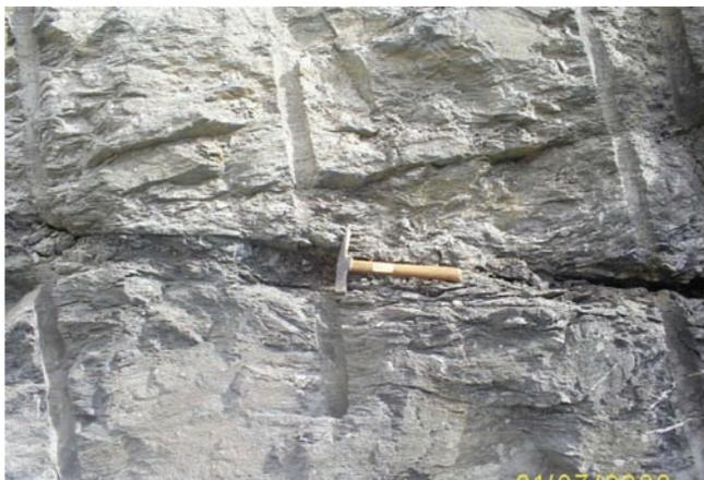
**Fig. 5** – UHE Serra do Facão: Muro de encontro montante (El. 670,0), parede NW - descontinuidade sub-horizantal.
