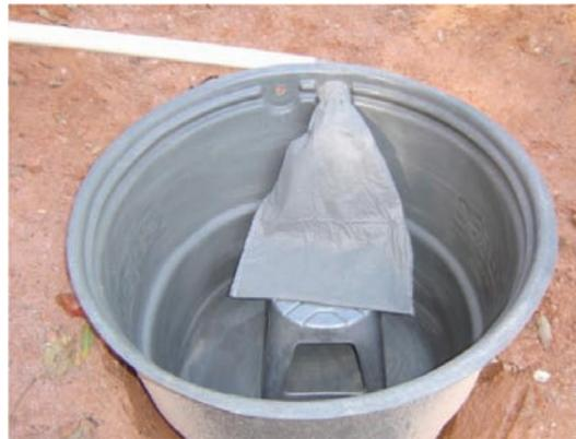
**Fig. 8** – Tanque com a bolsa de geotêxtil.
