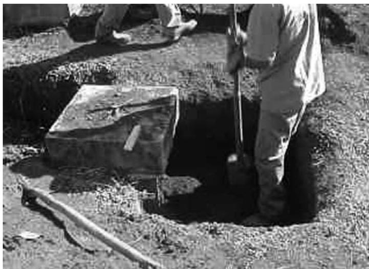
**Fig. 6** – Preparação do solo-cimento compactado no campo.
