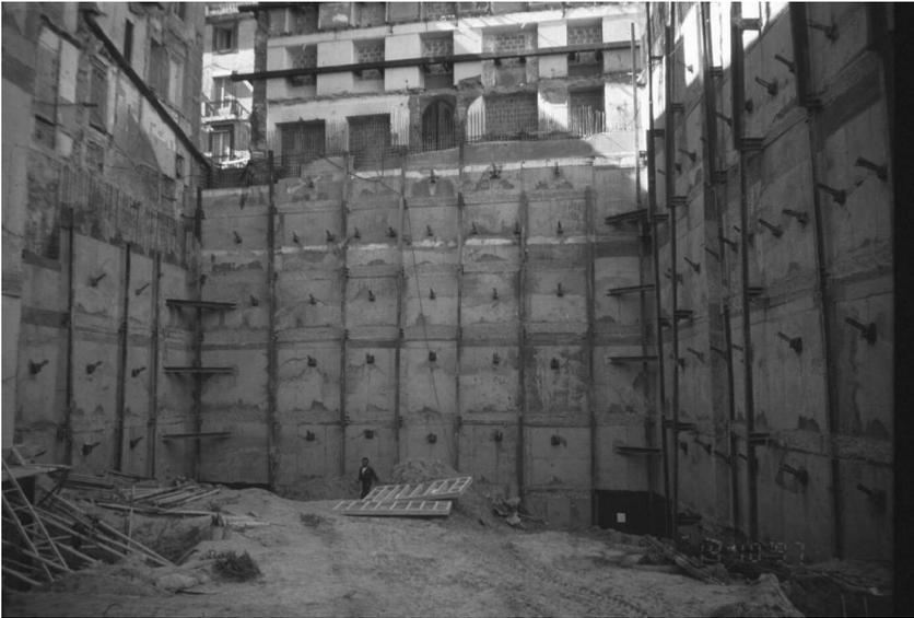
**Fig. 1** - Perfis exteriores em estrutura de contenção tipo Berlim.
