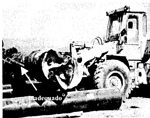
Fig. 2 – Exemplo de um transporte inadequado de um geotêxtil.
