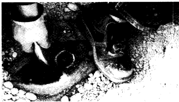
Fig. 8 – Exemplo de orifício na geomembrana por punção.
