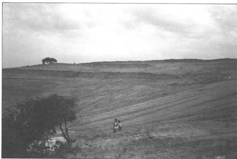
Foto 3 - Aspecto de uma parte da área recuperada. Notar as curvas de nível baixas e sem nenhuma proteção vegetal.
