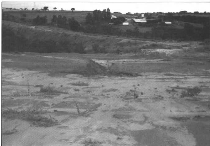
Foto 4 - Curva de nível com rompimento parcial nas primeiras chuvas mais intensas do verão de 1992.
