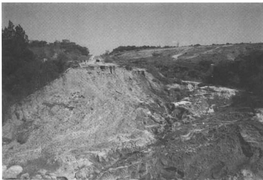
Foto 7 - Vista do aterro rompido devido ao acúmulo de água decorrente do assoreamento do canal de drenagem.
