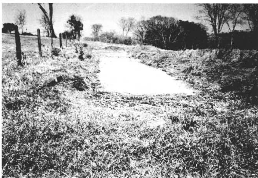
Fig. 4 – Cava preenchida com resíduos industriais.
