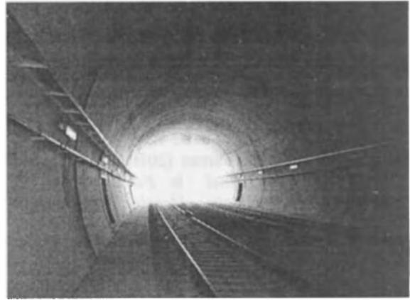
Fig. 10 – Aspecto do túnel após a execução do revestimento definitivo.
