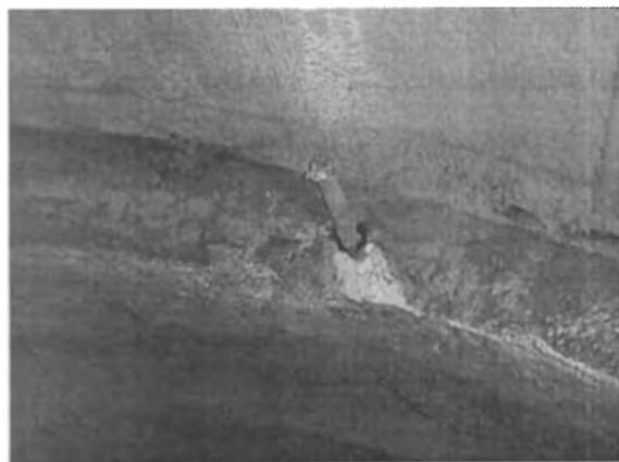
Fig. 8 – Drenos profundos inseridos nos pré-arcos.
