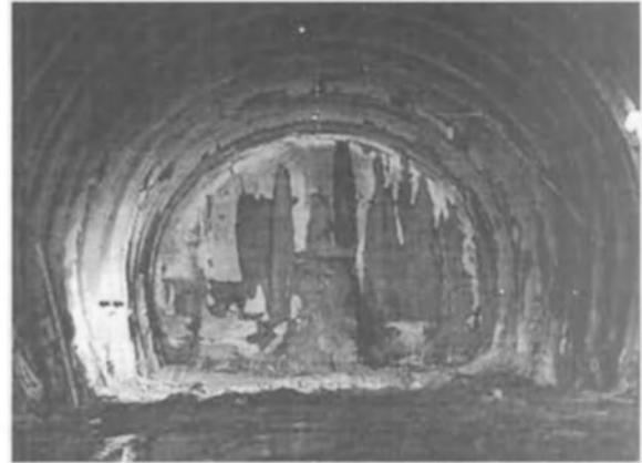
Fig. 4 – Vista do interior do túnel no final de um ciclo de avanço.
