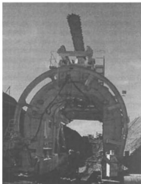
Fig. 3 – Equipamento de pré-corte, onde é visível a serra de corrente, bem como a bomba de projecção de betão (inferiormente à esquerda).
