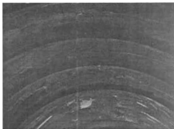
Fig. 9 – Colocação sistemática de cambotas metálicas de reforço.
