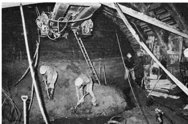
Fig. 4 — Execução da obra na zona da frente
