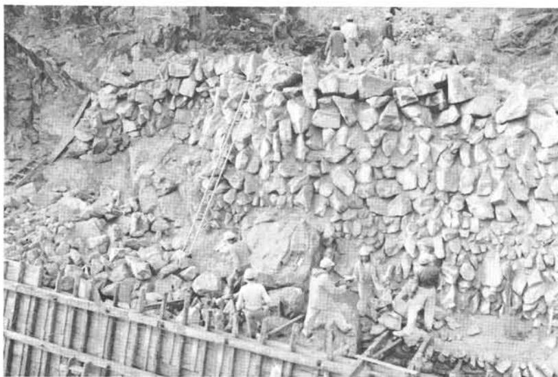
*Fig. 5 — Execução do enrocamento argamassado em reentrâncias afastadas do paramento*
