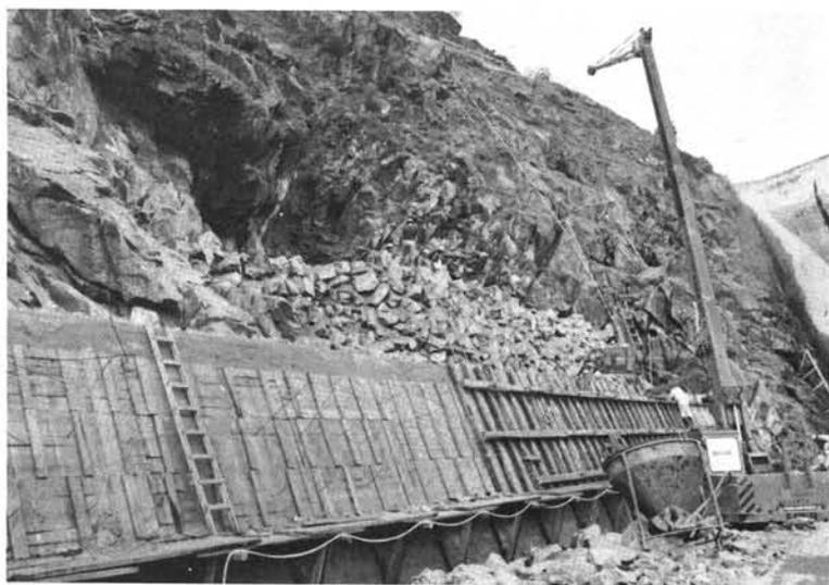
*Fig. 7 — Na parte superior, preenchimento duma reentrância com enrocamento argamassado. Inferiormente, execução do paramento.*
