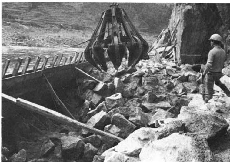
*Fig. 6 — Execução do enrocamento argamassado junto à cofragem do paramento*
