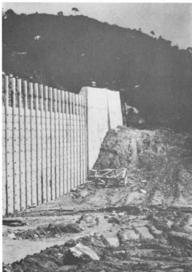
*Fig. 7 — Cortina de micro-ancoragens na variante Quintadinha-Bingen, na Rodovia Rio-Petrópolis. A cortina é associada lateralmente, a muros de peso. (Construtora Ferreira Guedes — DNER).*
