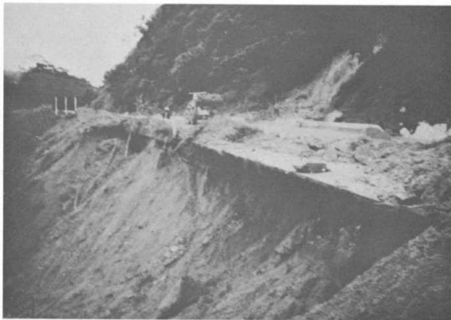
*Fig. 25 — Destruição da pista da Rodovia Rio-Teresópolis pela erosão provocada por chuvas excepcionais (1981).*
