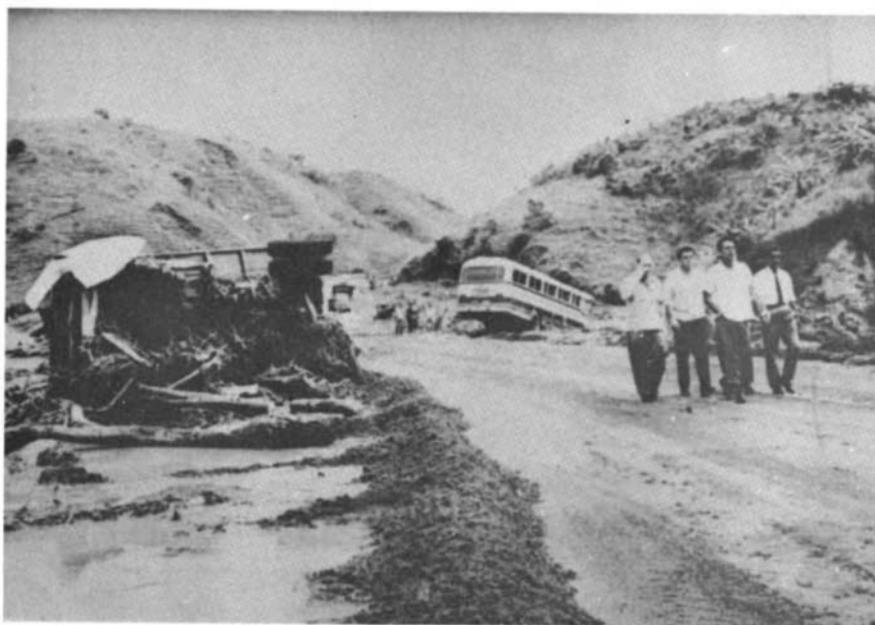
*Fig. 27 — Veículos arrastados pelo enxurro provocado por deslizamentos causados por chuvas excepcionais. Serra das Araras. Estado do Rio de Janeiro — 1967 (Foto DNER).*
