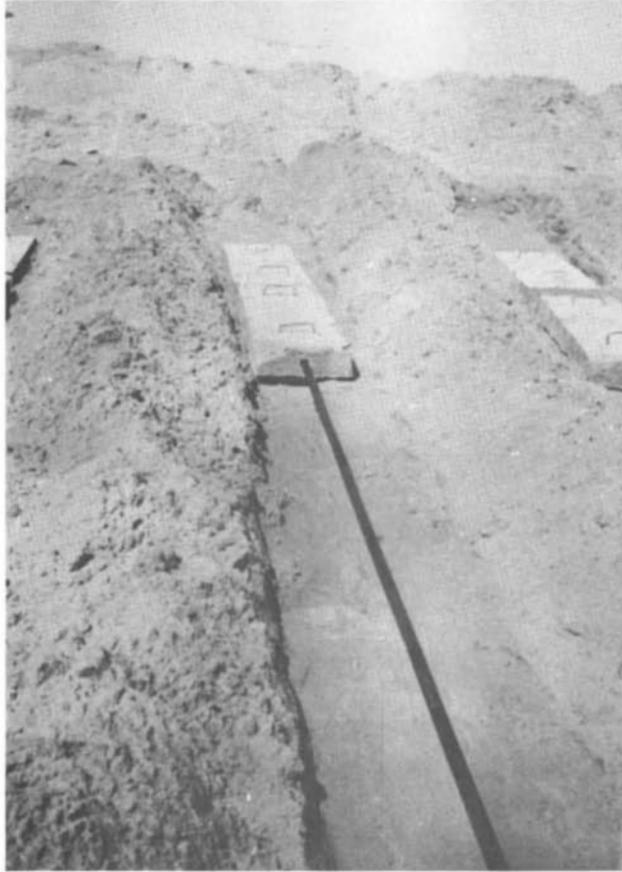
*Fig. 5 — Colocação de placas de micro-ancoragens sobre um aterro em curso. Note-se que os tirantes são protegidos da corrosão pelo envolvimento em um tubo de plástico, além da proteção por dupla pintura (obra da estrada Litorânea-Natal. Veja-se foto n.º 6).*
