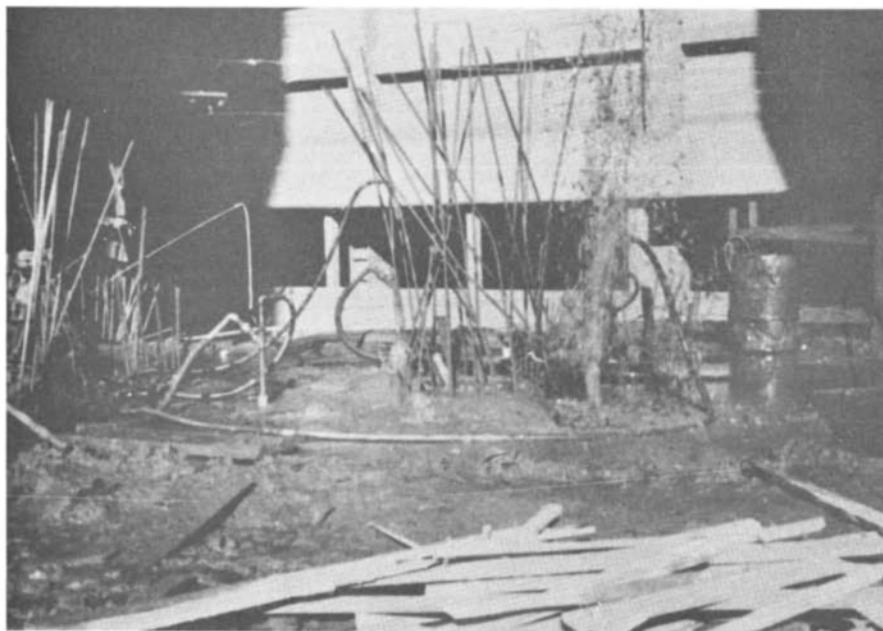
*Fig. 17 — Lavagem de material de preenchimento de cavernas cársticas, como providência preliminar ao seu preenchimento por injeções de cimento-argila. Fábrica de Cimento Votoran — Estado de São Paulo.*
