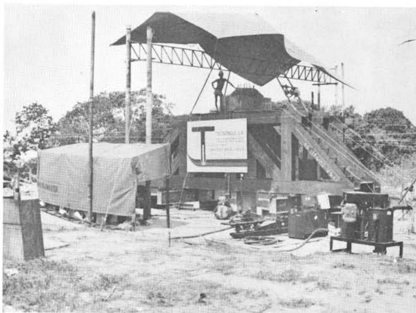
*Fig. 3 — Prova de carga — Camaçari*
