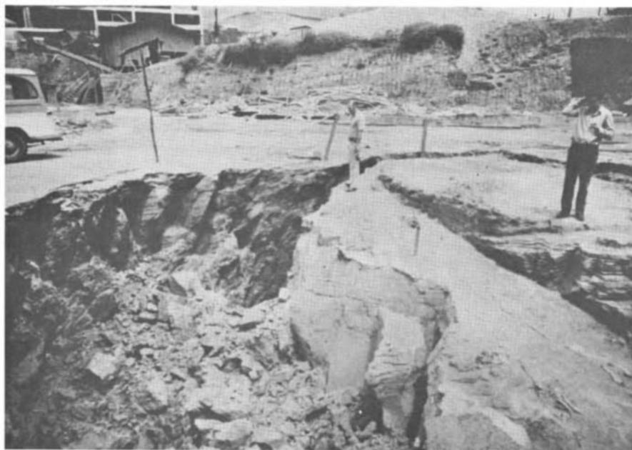
*Fig. 15 — Dolina cárstica na Fábrica de Cimento de Capão Bonito.*
