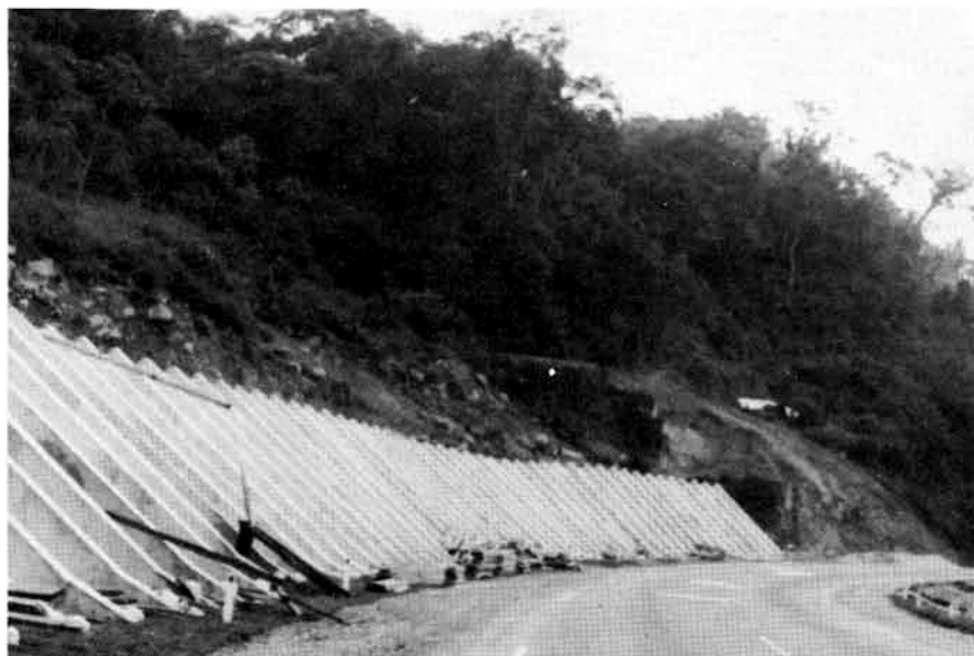
Foto 3 – Estabilização de taludes em corte de talus na Rodovia Curitiba-Paranaguá – BR. 277 – DNER
