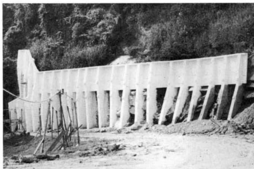
Foto 10 – Muro de impacto na zona de deslizamento das Laranjeiras – DER GB e Instituto de Geotécnica
