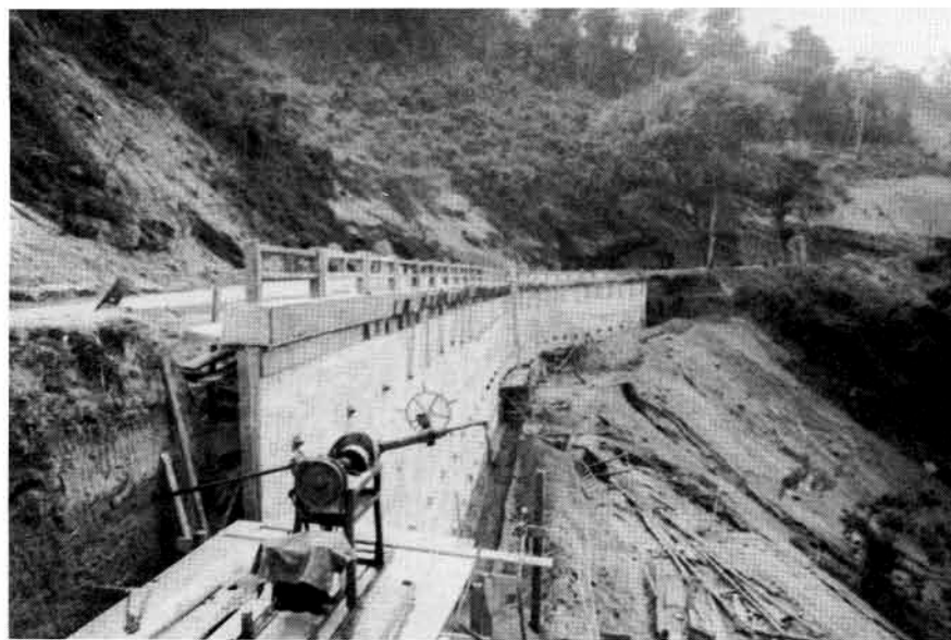
Foto 4 – Estabilização na pista de descida da Serra das Araras – DNER
