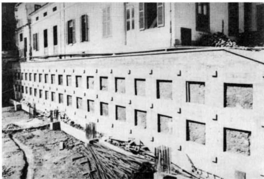
Foto 6 – Cortina em grelha em solo residual – Obra pioneira Beneficência Portuguesa
