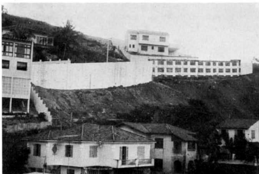
Foto 7 – Cortina de estabilização de taludes e grelha de reforço de muro de alvenaria na Rua Stefan Zweig nas Laranjeiras GB – DER GB e Inst. de Geotécnica
