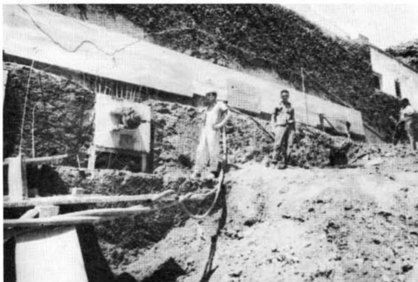
Foto 5 – Execução de estabilização pelo método brasileiro de submuramento – Obra pioneira Beneficência Portuguesa.
