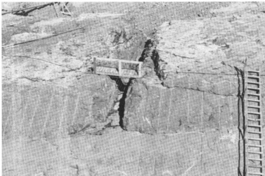
*Fig. 15 – Maciço basáltico com fendas devidas a libertação de tensões iniciais*
