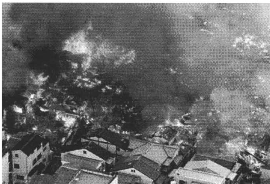
Fig. 10 – Incêndio urbano causado pelo sismo de Kobe, 1995-01-17, Japão (Fonte: Universidade de Nevada, EUA – http://www.seismo.unr.edu ).
