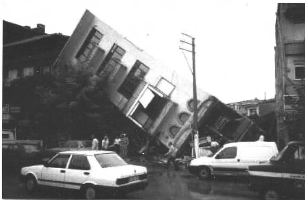
Fig. 19 – Rotura da fundação de um edifício devida a liquefacção de solos no sismo de Kocaeli, 1999-08-17, Turquia (Fonte: Earthquake Engineering Research Institute , EUA – http://www.eeri.org ).
