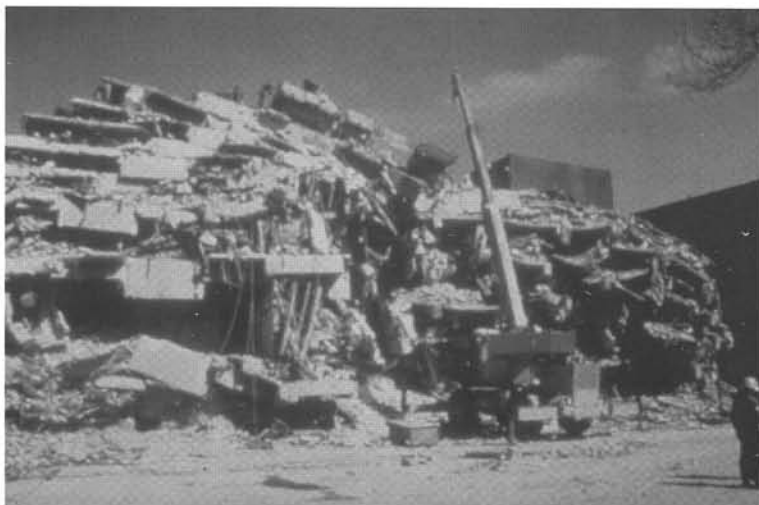
Fig. 22 – Colapso total de um edifício hospitalar na cidade do México no sismo de Michoacan, 1985-09-19, México (Fonte: John A. Martin and Associates – http://www.johnmartin.com ).
