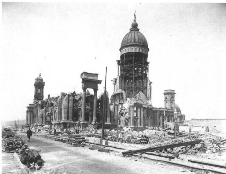
Fig. 4 – Colapso do City Hall da cidade de S. Francisco no sismo de S. Francisco, 1906-04-18, EUA (Fonte: ZPUB – http://zpub.com ).
