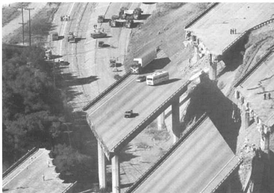
Fig. 5 – Colapso de viaduto rodoviário no sismo de Northridge, 1994-01-17, EUA (Fonte: United States Geological Survey , EUA – http://geopubs.wr.usgs.gov ).
