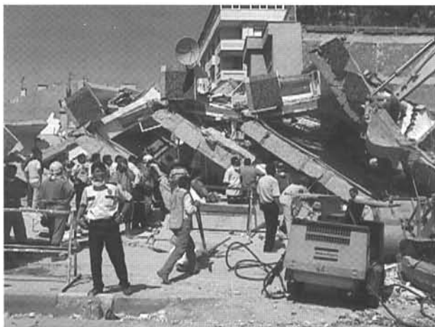
Fig. 29 – Colapso de edifício em Avclar no sismo de Kocaeli, 1999-08-17, Turquia (Fonte: Universidade do Bósforo, Turquia – http://www.koeri.boun.edu.tr ).
