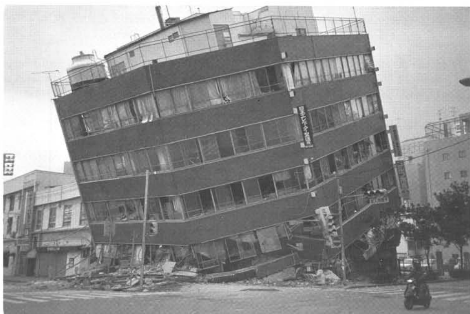
Fig. 26 – Colapso de edifício na cidade de Kobe no sismo de Kobe, 1995-01-17, Japão (Fonte: National Geophysical Data Center , EUA – http://www.ngdc.noaa.gov ).
