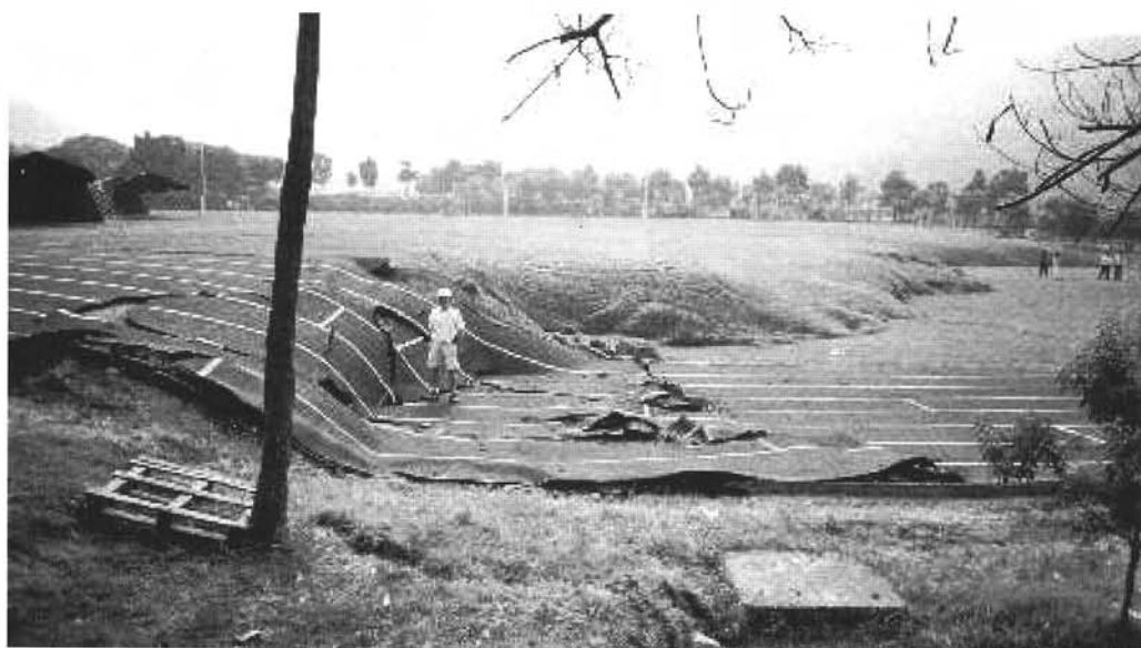
Fig. 3 – Expressão superficial da rotura na falha de Chelengpu no sismo de Ji-Ji, 1999-09-20, Taiwan (Fonte: Universidade da Califórnia, Berkeley, EUA – http://nisee.berkeley.edu ).
