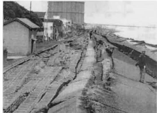
Fig. 25 - Deslocamentos pós-liquefacção (sismo de Kobe, 1995).
