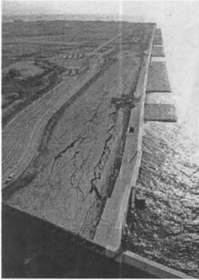
Fig. 29 - Rotura de um muro de suporte durante o sismo de Kobe (1995).
