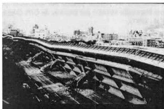
Fig. 30 - Rotura de fundação de um viaduto durante o sismo de Kobe (1995).
