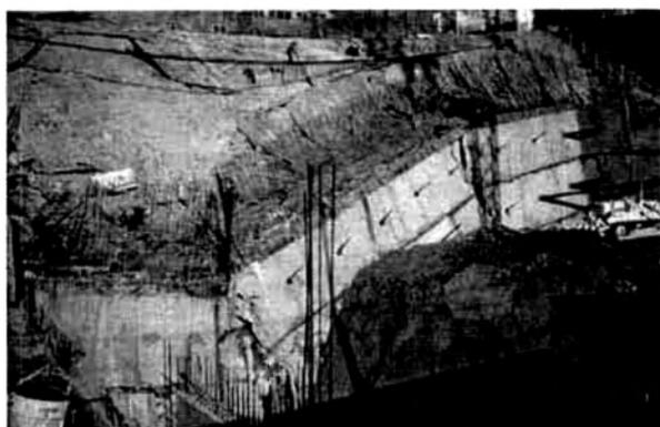
Fig. 2 - Rotura de uma cortina tipo Berlim, envolvendo perda de equilíbrio vertical (Guerra, 1999).
