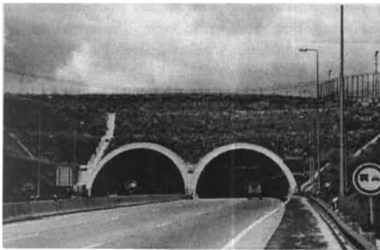
Fig. 21 – Túnel do Grilo.
