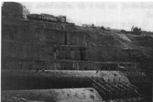
Fig. 22 – Aspecto dos taludes do túnel do Grilo (Barradas et al. , 2002).
