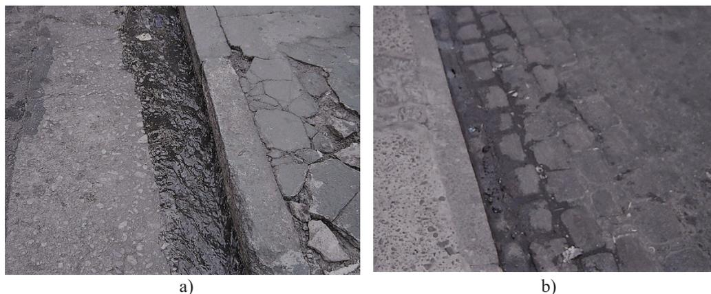
**Fig. 2** – a) Guia e sarjeta convencional para condução de vazões superficiais e (b) guia e faixa lateral de infiltração das águas no subleito.
