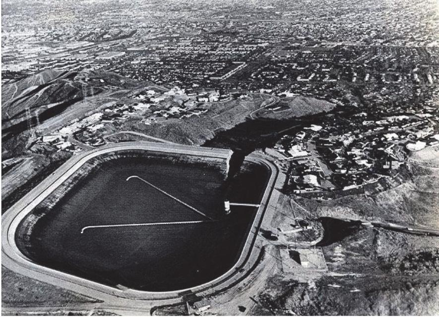
**Fig. 7** – Vista geral do Reservatório de Baldwin Hills após rotura na zona da barragem, bem como da zona habitacional inundada a jusante.
