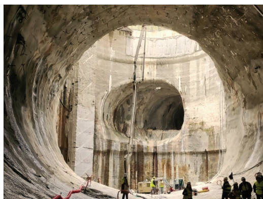
d) Vista geral após conclusão da CM
