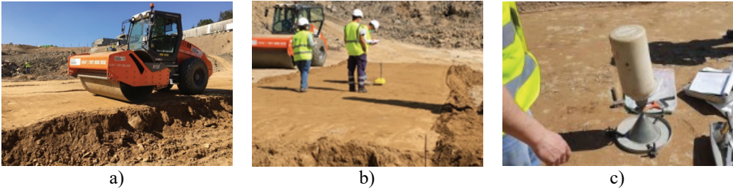
Fig. 19 – a) Compactação da camada do trecho experimental; b) controlo do grau de compactação com o gamadensímetro; c) aferição do grau de compactação com o ensaio da garrafa de areia.
