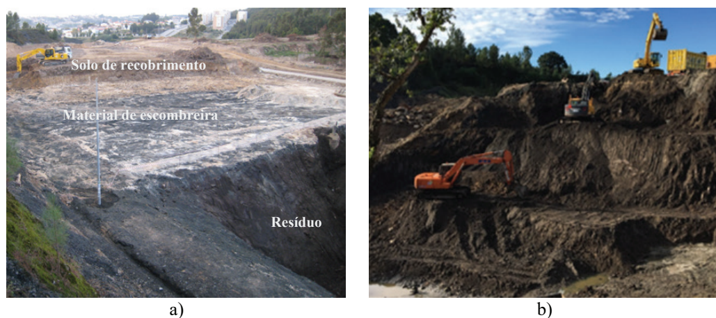
Fig. 14 – a) Litologias constitutivas do depósito; b) escavação e carregamento dos resíduos com retroescavadoras.
