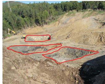
Fig. 5 – Bacias escavadas no terreno subjacente ao depósito de resíduos.
