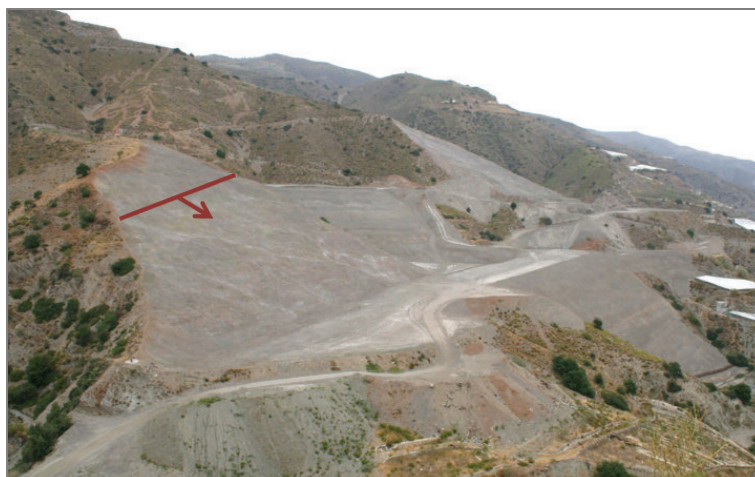
Fig. 2 – Vista de uno de los grandes taludes de la zona indicándose la dirección de buzamiento y buzamiento de las capas.
