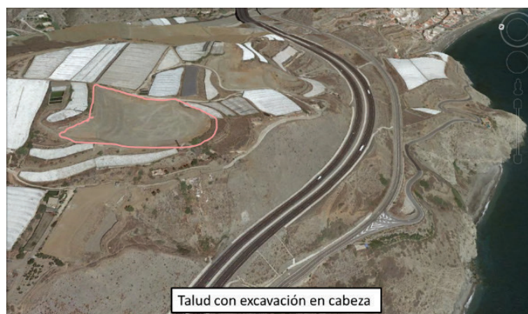
Fig. 10 – Vista del estado actual del talud con la excavación (línea rosa) realizada en la zona superior de ladera.
