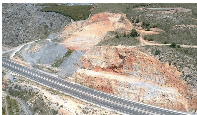
Fig. 20 – Vista del estado actual del talud en 2025.
