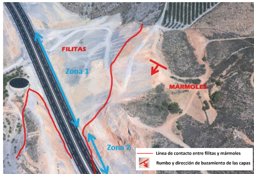
Fig. 14 – Vista de la disposición de mármoles y filitas en el talud.
