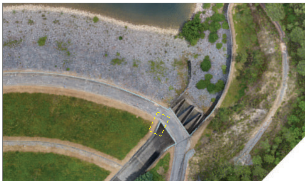
Fig. 34 – Localização da zona onde ocorrem fissuras junto ao descarregador, no talude de jusante.
