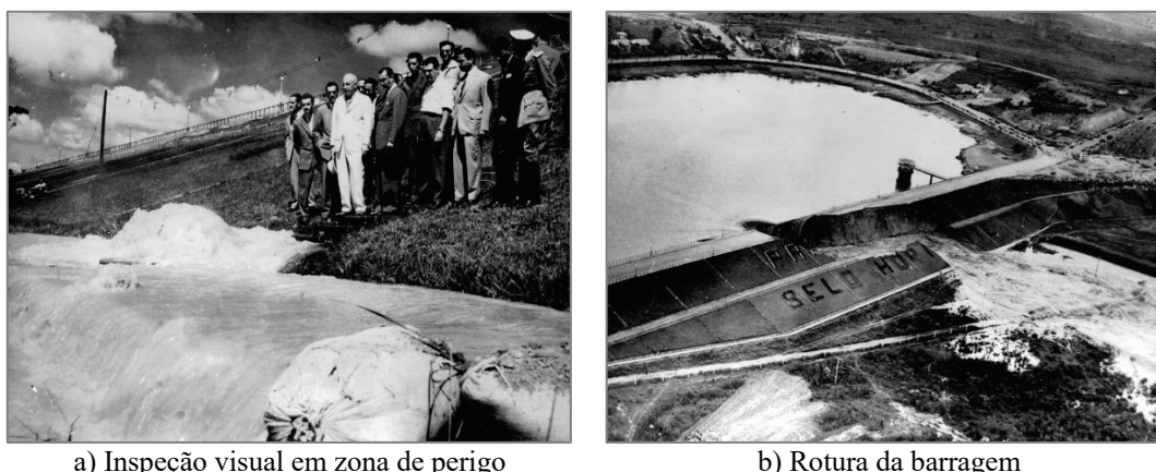
Fig. 1 – Rotura da Barragem da Pampulha (18/04/1954) (Guidicini et al., 2021).
