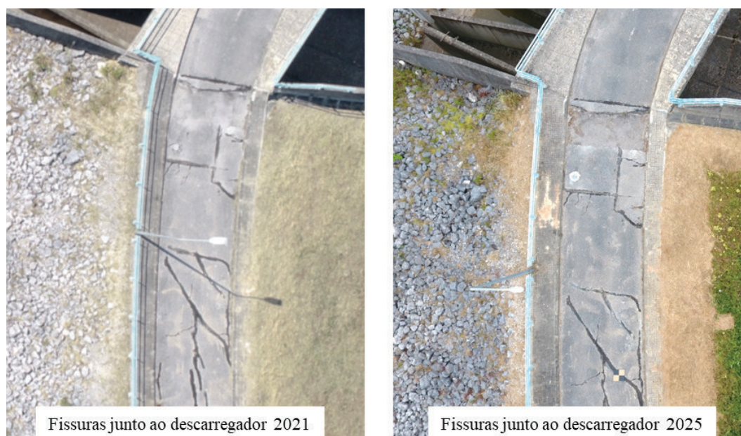
Fig. 33 – Fissuras no coroamento, junto ao passadiço do descarregador. Comparação entre as campanhas de 2021 e 2025.
