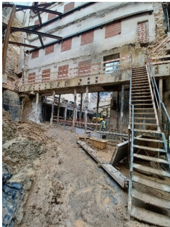
Fig. 7 – Recalçamento de fachada.
