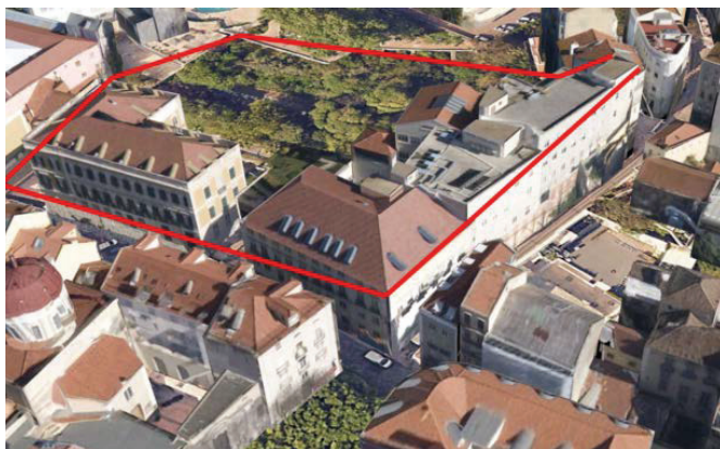
Fig. 3 – Vista 3D dos edifícios e arruamentos adjacentes (imagem do Google Earth, 2022).
