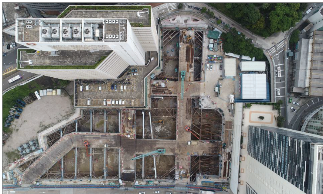
Fig. 4 – Escoramentos com recurso a elementos metálicos em obra de escavação em Macau.
