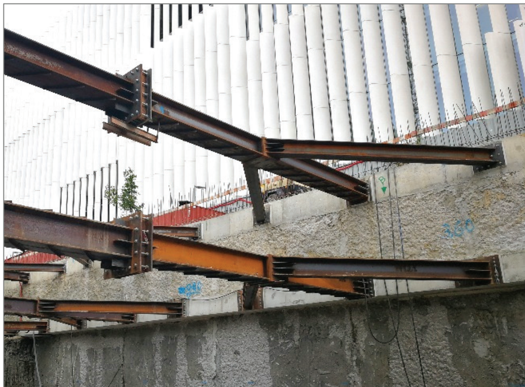
Fig. 3 – Escoramentos com recurso a elementos metálicos pré-esforçados (Estorninho, 2020).
