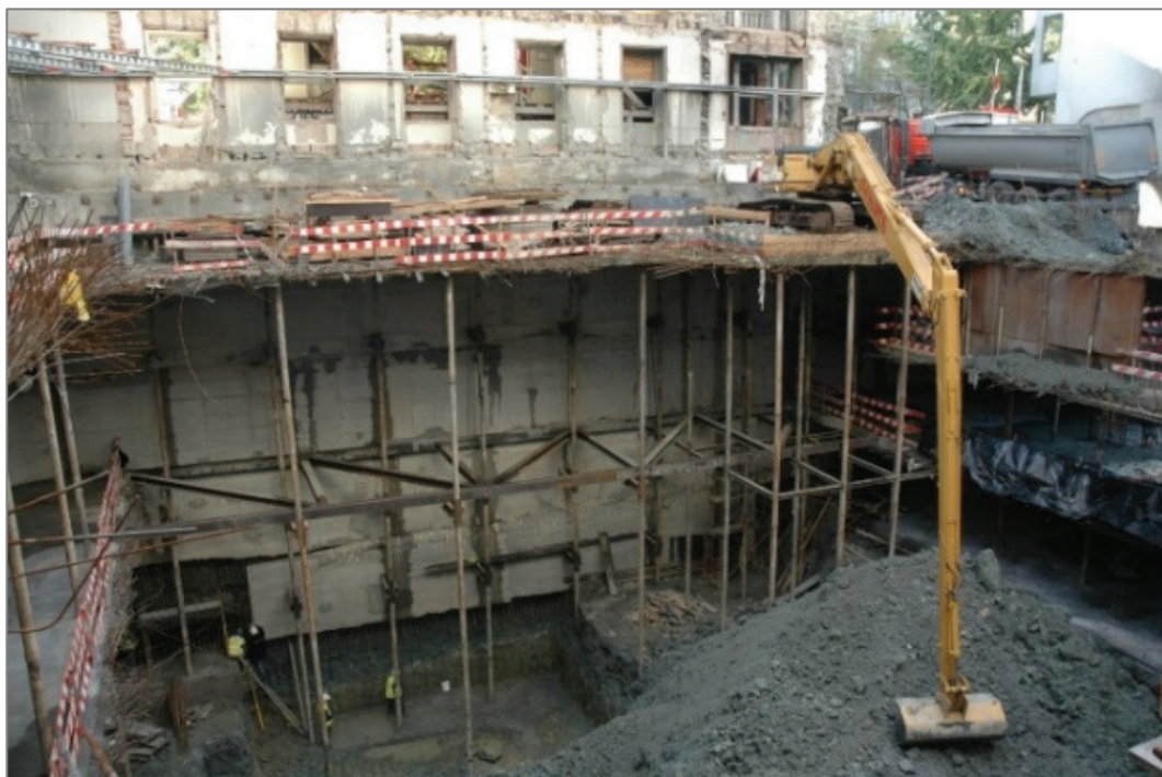
Fig. 17 – Exemplo da logística otimizada associada a trabalhos de escavação em obra em que a parede de contenção periférica foi travada por bandas de laje (Pinto e Pita, 2010).
