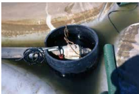
Fig. 5 – Esquema de instalação de contrapesos e flutuadores e poço da bomba para remoção da água meteórica
