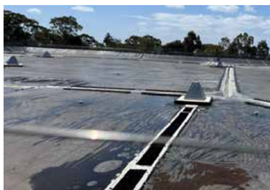
Fig. 11 – Agitadores flutuantes e labirinto de cortinas defletoras para circulação da água.
