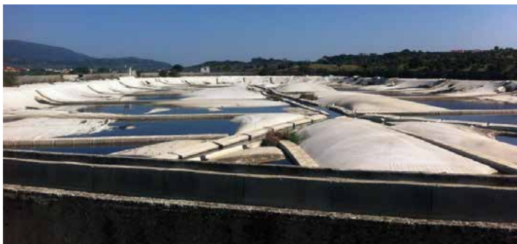
Fig. 13 – Cobertura da lagoa de Alcanena em total abandono após 17 anos de serviço (2014).
