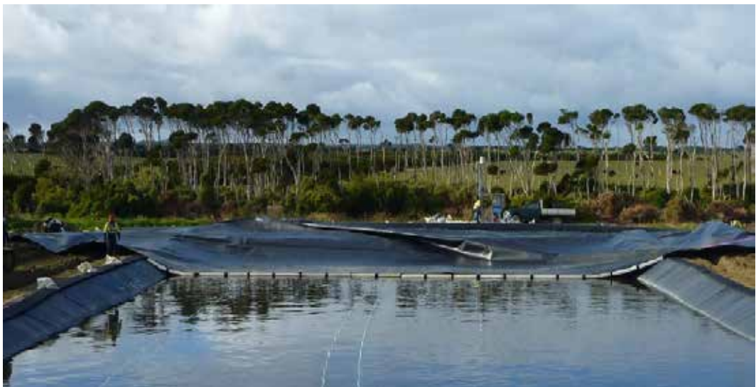
Fig. 2 – Instalação de uma cobertura flutuante sobre um reservatório de água residual.
