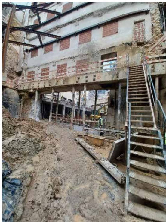
Fig. 7 – Recalçamento de fachada.
