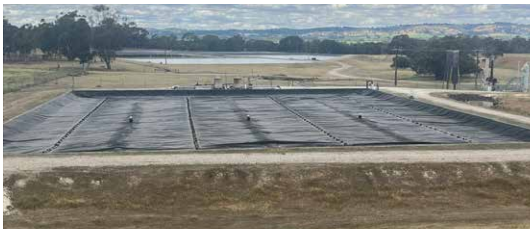
Fig. 10 – Digestor com cobertura flutuante de nível constante.
