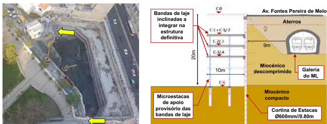
Fig. 13 – Contenção periférica no edifício FPM41 (Pinto et al., 2017).
