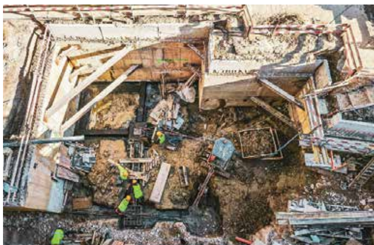
Fig. 13 – Execução das fundações definitivas conforme proposto para a estabilização das deformações.
