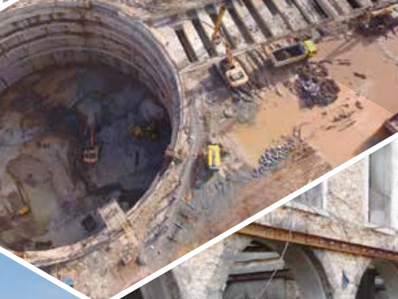
Poço de minério Kamsar, Guiné
