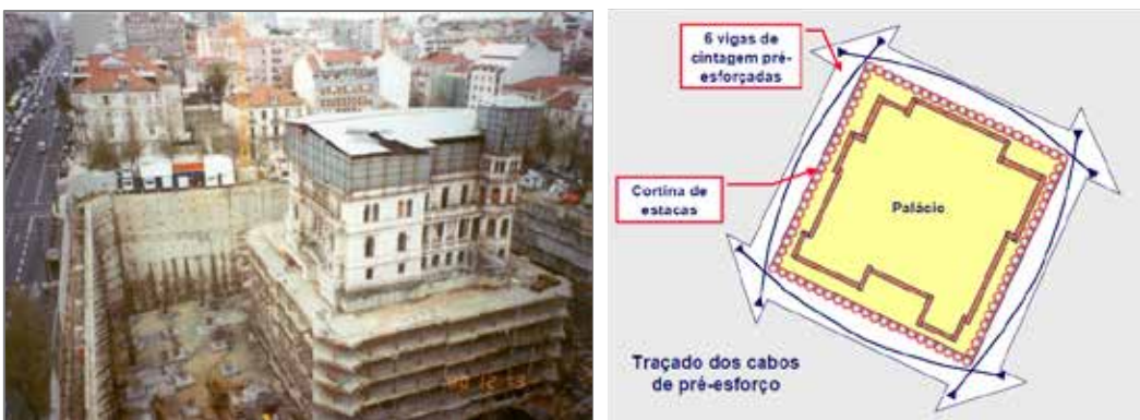
Fig. 12 – Contenção periférica do Palácio Sotto Mayor (Pinto et al., 2001, 2002a e 2002b).
