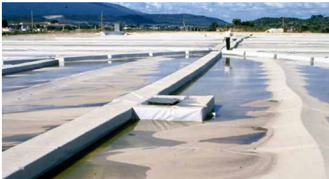
Fig. 8 – Escotilha de visita da cobertura de Alcanena (Machado do Vale et al., 1998).
