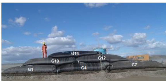
(b) Empilhamento drenado - direção horizontal
