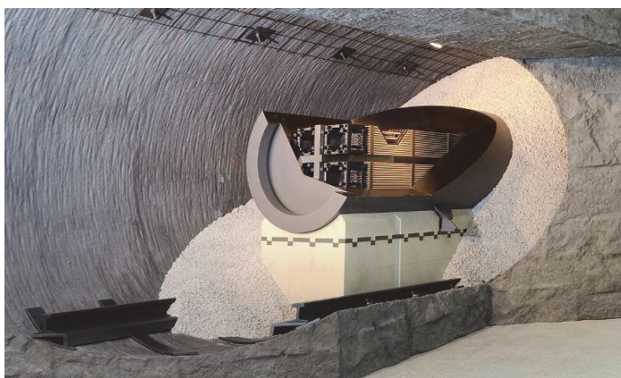
Fig. 4 – Concepto de barrera de bentonita de NAGRA (agencia suiza de residuos radioactivos) combinado bloques de bentonita con bentonita granular.
