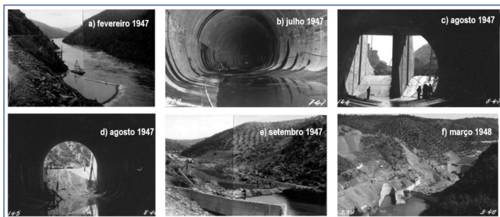
Fig. 7 – Castelo do Bode. Derivação provisória: a) trabalhos iniciais; b), c) e d) secção corrente, entrada e saída do túnel de derivação; e) leito do rio a seco; f) enscadeiras (vista de jusante).
