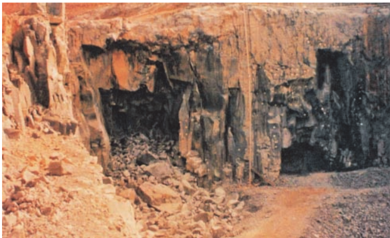
Fig. 10 – UHE Foz do Areia. Desmoronamento no emboque dos túneis de desvio (CBDB, 2009).
