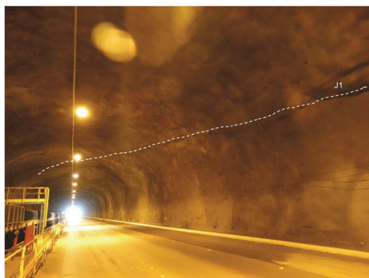
(a) Junta J1 sub paralela – E 51
