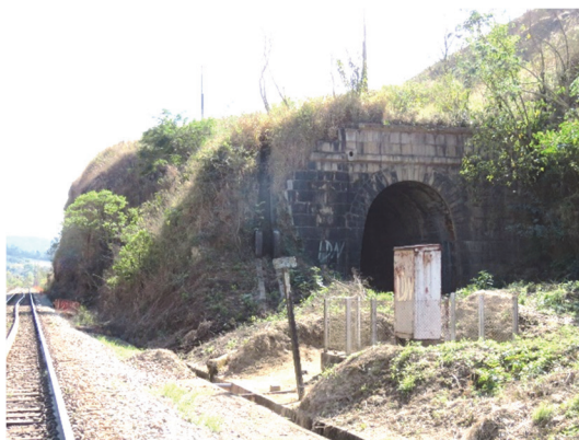
(a) Maciço do emboque com cicatriz de ruptura
