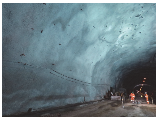
(a) Chumbadores e drenos profundos – Junta J2
