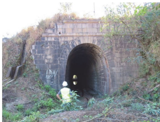
(b) Perda de blocos e bica e marquise de drenagem do espelho
