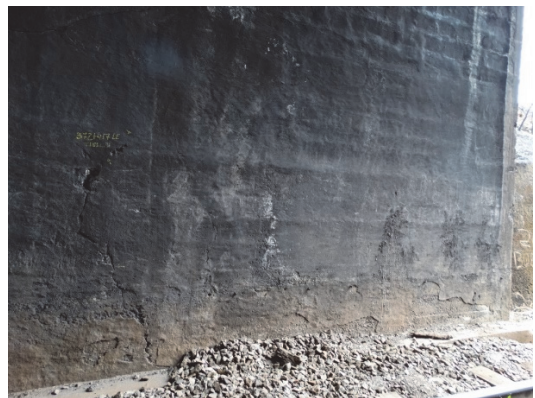
(b) Trinca inclinada aberta na lateral do emboque
