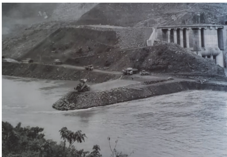
Fig. 8 – UHE Foz do Areia. Ensecadeira em construção, com os túneis desvio do rio na margem direita.
