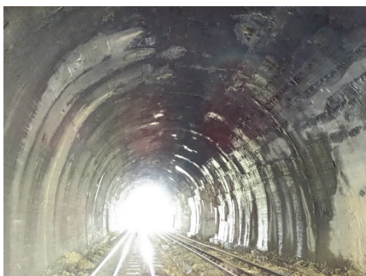
(a) Trincas longitudinais e no perímetro da seção
