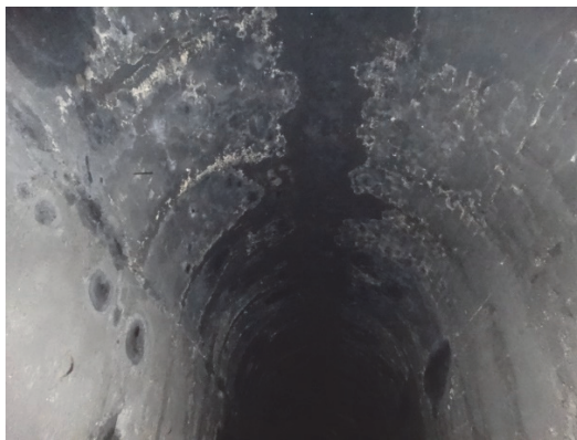
(a) Trincas nas regiões de rim e na abóbada
