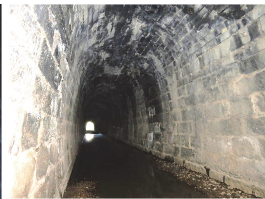
(b) Infiltrações expressivas na abóbada e paredes com deterioração e perda de argamassa
