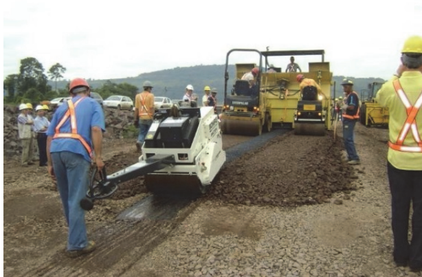
Fig. 34 – Jirau. Máquina pavimentadora e rolos compactadores em atividade.
