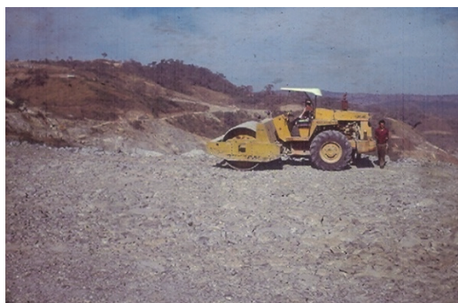
(f) Compactação do enrocamento com rolo liso vibratório, aba jusante
