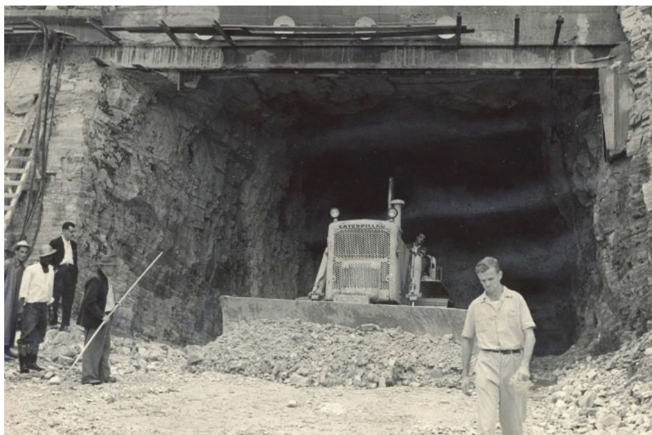
Fig. 5 – Barragem de Furnas. Construção do túnel de desvio.
