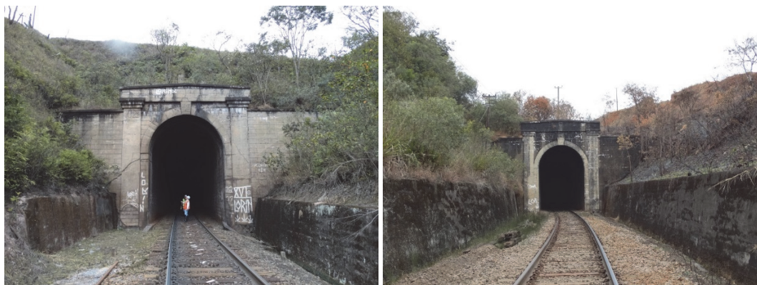
(a) Emboque com cobertura reduzida
