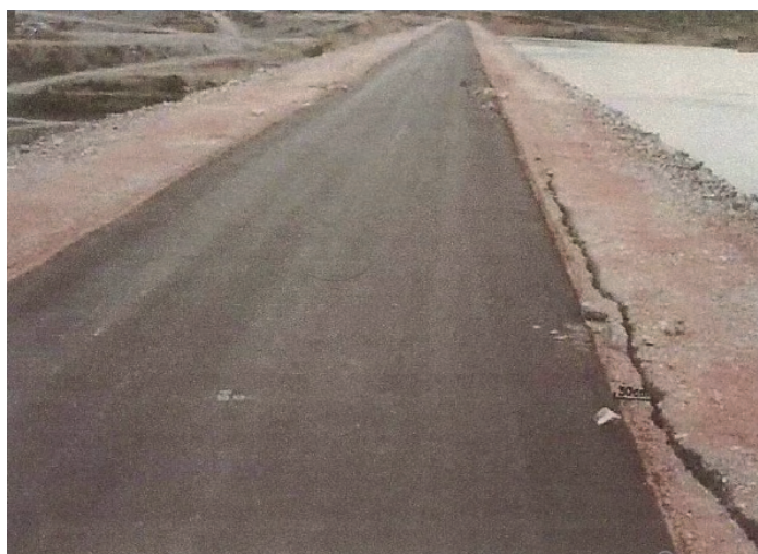
Fig. 22 – Emborcação. Trincas longitudinais na crista da barragem após o enchimento do reservatório.
