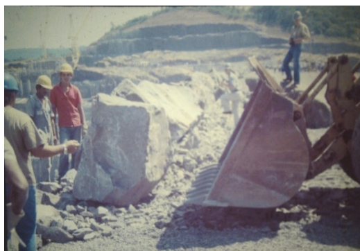
(d) Posicionamento dos blocos na face jusante
