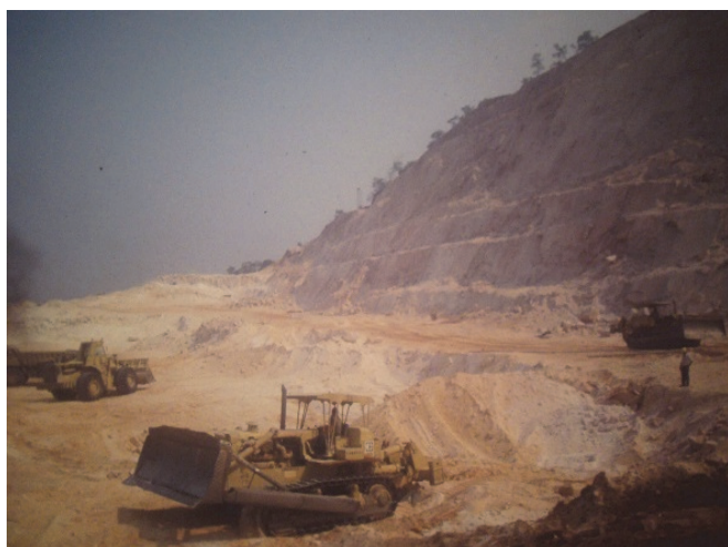
(b) Pedreira de quartzito para material das transições
