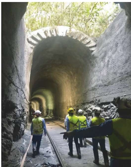
(b) Concreto projetado na área da janela
