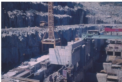
(a) Construção da casa de força, ombreira esquerda
