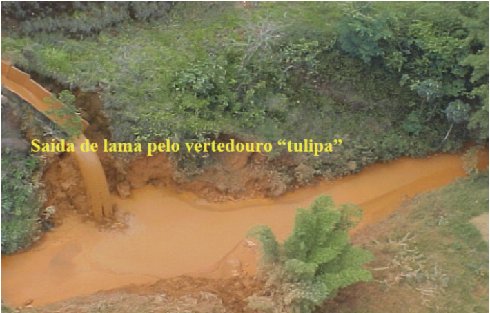
Fig. 20 – Vazamento da lama pela galeria do sistema extravasor da Barragem São Francisco (CAOMA, 2006b)
