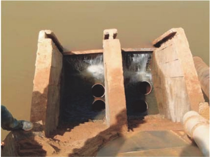
Fig. 19 – Barragem São Francisco. Células, abertas do lado do reservatório, para drenagem da água (CAOMA, 2006b)
