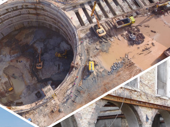
Poço de minério Kamsar, Guiné
