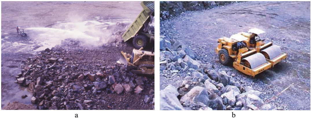
Fig. 2 – Construção de um aterro de enrocamento compactado: a) a técnica indispensável para a adequada colocação e molhagem duma camada de enrocamento; b) cilindros vibradores para a compactação da camada de enrocamento.
