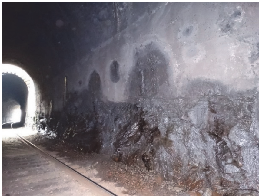
Fig. 26 – Potencial de desprendimento de bloco e infiltrações contínuas no trecho não revestido.
