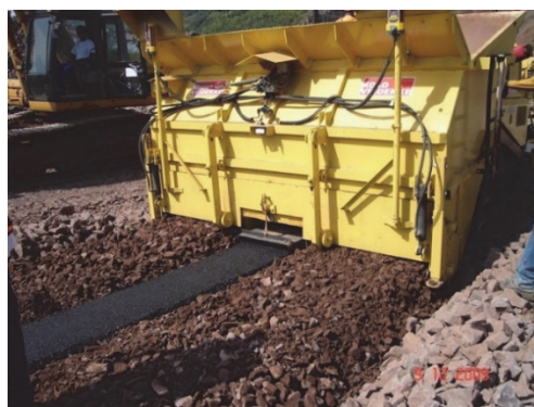
(a) Lançamento do núcleo asfáltico e transições da barragem
