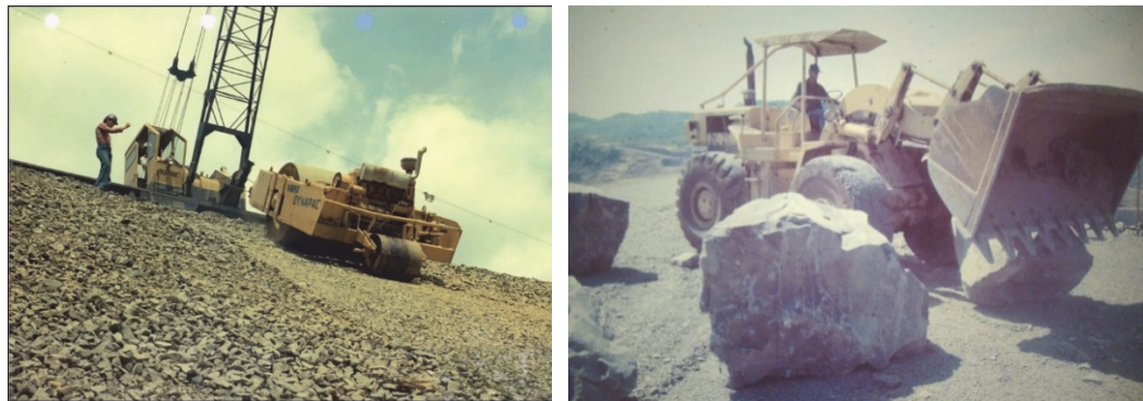
(a) Compactação da transição com rolo vibratório
