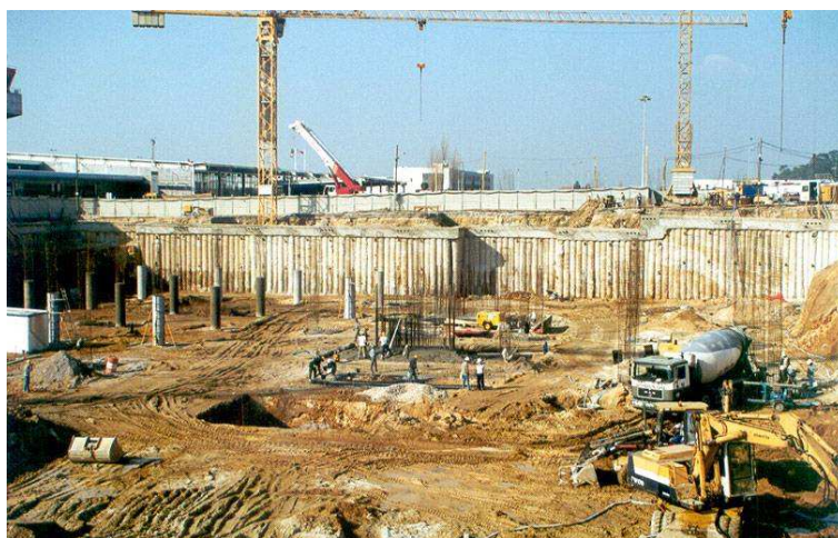
Fig. 15 – Cortina de estacas secantes de betão simples e de betão armado, Aeroporto Francisco Sá Carneiro, Porto, 2001 (gentileza de Teixeira Duarte, Lisboa).
