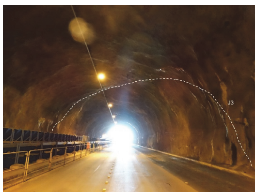
(a) Junta J3 vista para o desemboque
