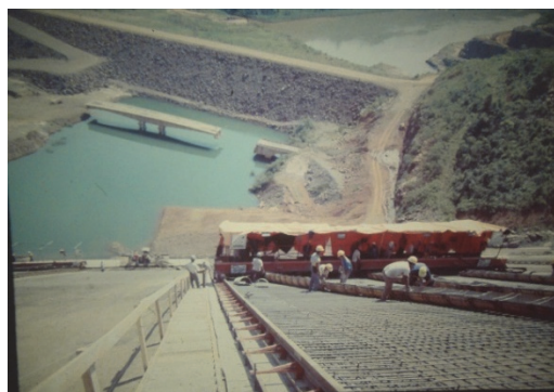
(c) Concretagem da laje na face montante
