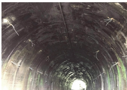
(b) Chumbadores preparados para fase de injeção
