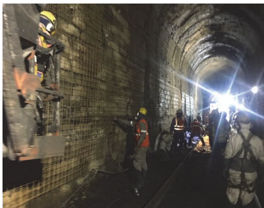
(b) Reforço com tela na parede degradada
