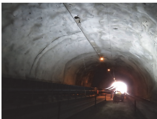
(b) Chumbadores e drenos profundos – Junta J3
