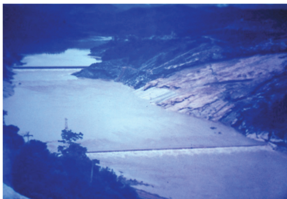
Fig. 26 – Serra da Mesa. Galgamento da barragem (1ª fase) durante uma cheia do Rio Tocantins.
