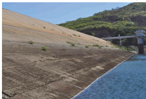
(b) Placas de concreto na face montante
