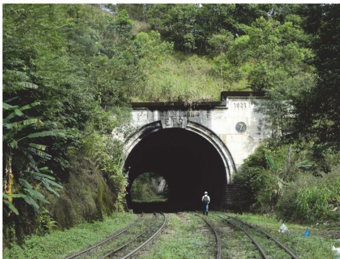
Fig. 15 - Túnel 7 escavado em encosta de solo e rocha com cobertura variável sendo muito reduzida no desemboque.
