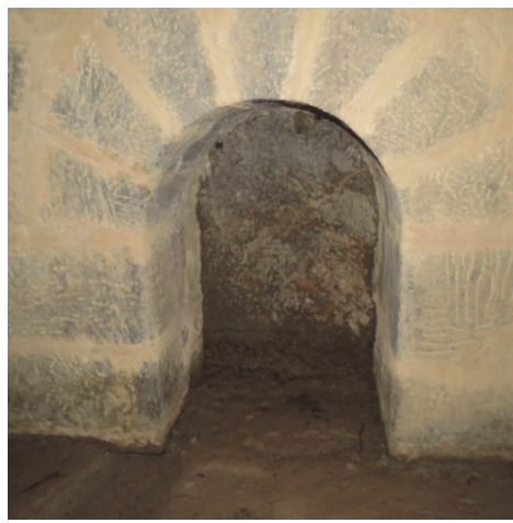
(b) Nicho com 0,6m de depósito de finos –desemboque
