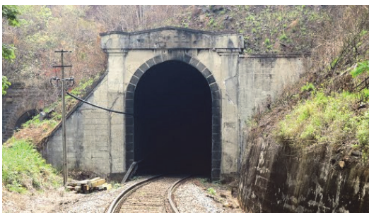
(b) Túneis 27 de 1876 e 1948 em serviço
