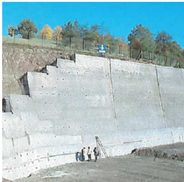
Fig. 13 – Imagem de escavação pregada, Stuttgart, 1980 (BAUER Spezialtiefbau GmbH).
