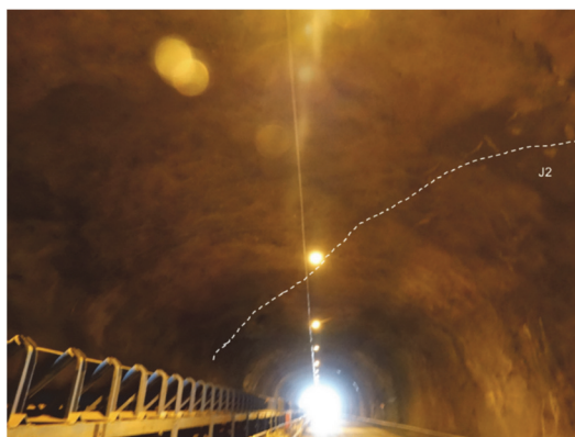
(b) Junta J2 com inclinação para lateral – E 69
