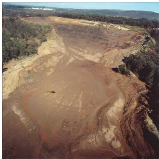
Fig. 7 – Mineração Rio Verde, vista aérea dos rejeitos após a ruptura
