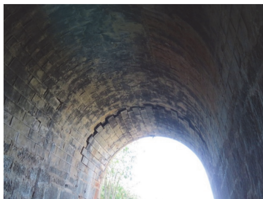
(a) Trinca aberta persistente na abóbada com deslocamento dos blocos próxima do emboque
