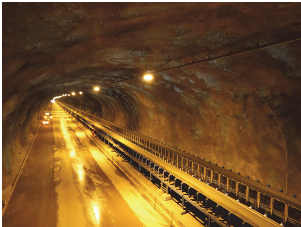
Fig. 31 – Túnel com 20,5m de largura com correias transportadoras e pista de veículos pesados.
