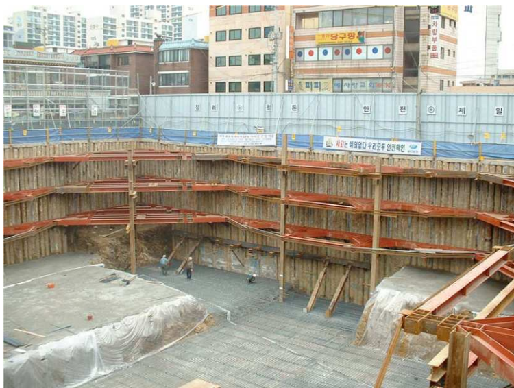
Fig. 23 – Imagem de escavação com o sistema de contenção escoras-arco atirantado pré-esforçado, Coreia do Sul (Park et al., 2009, com permissão da ASCE/with permission from ASCE).
