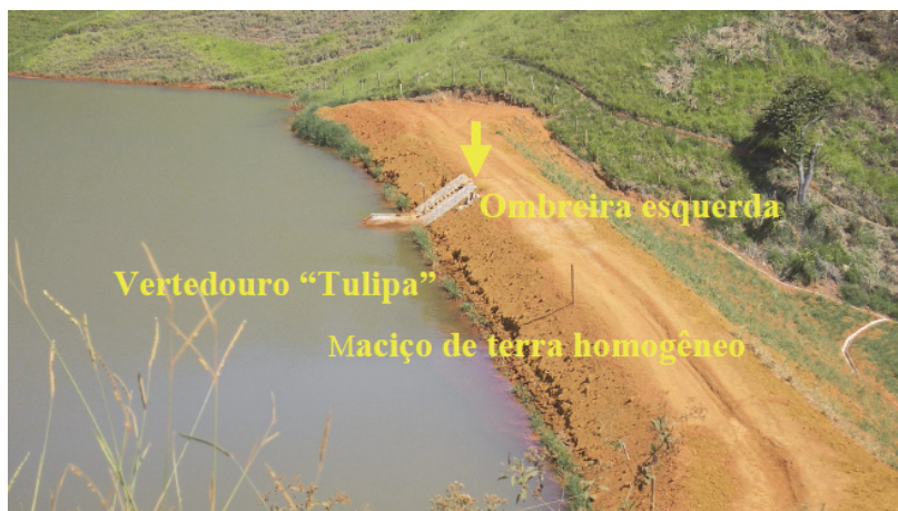
Fig. 18 – Barragem São Francisco. Detalhe da torre inclinada onde ocorria a tomada d’água do sistema extravasor (CAOMA, 2006b)
