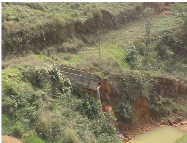
Fig. 17 – Saída do vertedouro da Barragem São Francisco, liberando o efluente no córrego Bom Jardim (CAOMA, 2006a).
