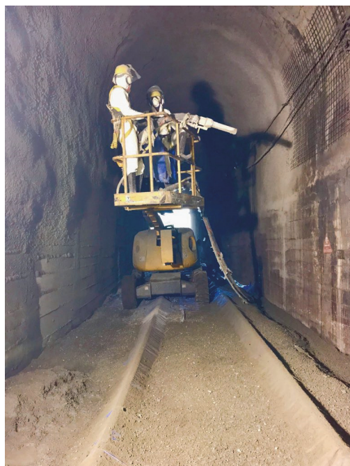
(a) Aplicação de concreto projetado
