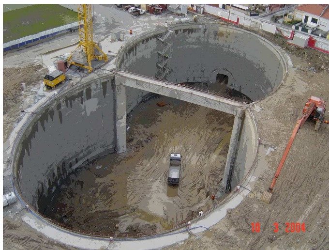
Fig. 18 – Duplo poço elíptico construído pelo método sequencial de escavação-betonagem, Estação Salgueiros, Metropolitano do Porto, 2004 (Topa Gomes et al., 2008).
