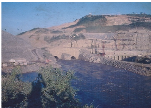
(c) Túneis e canal de desvio, lado jusante
