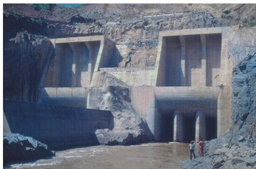
(b) Canal e túneis de desvio, lado montante
