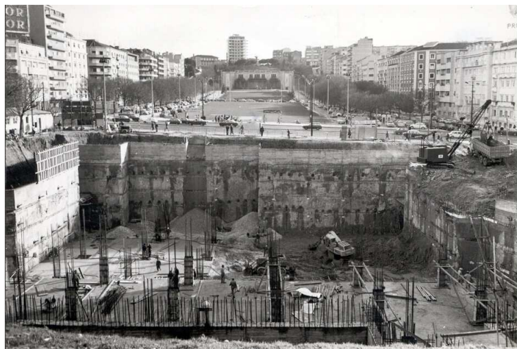
Fig. 7 – Cortina de paredes moldadas ancorada, parque de estacionamento da Alameda D. Afonso Henriques, Lisboa, 1974, fotografia de A. Campião (gentileza de Teixeira Duarte, Lisboa).
