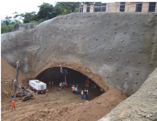
(a) Construção – Março 2011
