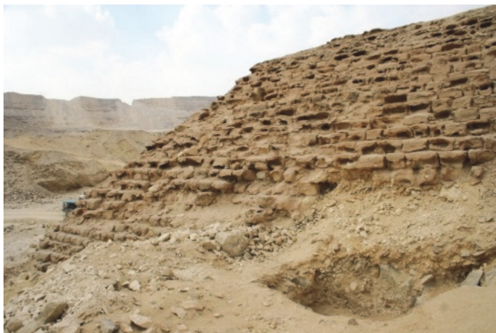
(a) Enrocamento na face de jusante.
