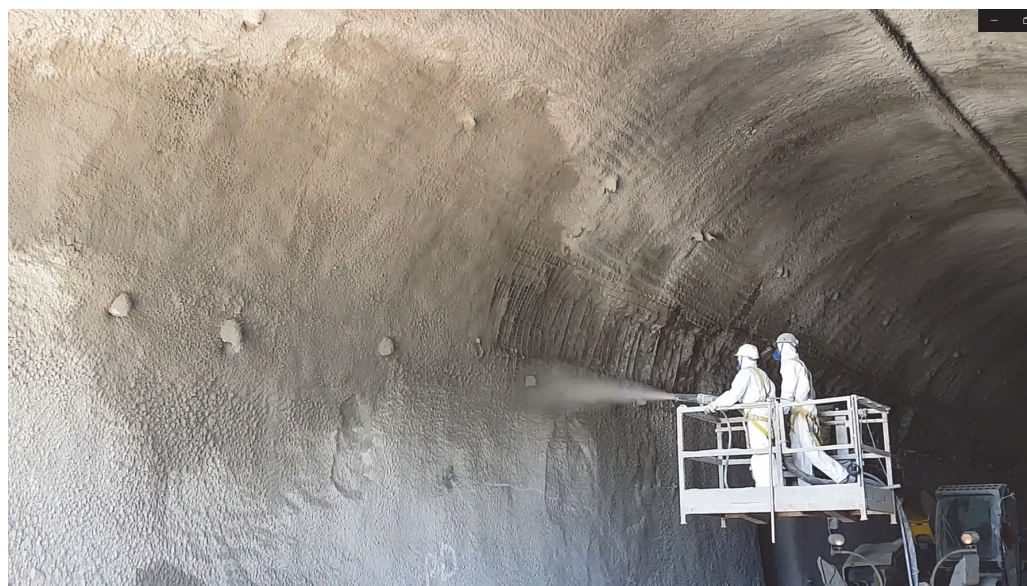
Fig. 22 - Aplicação de concreto projetado sem fibras metálicas, substituídas por tela eletrosoldada pela empreiteira.
