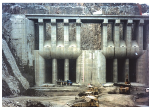
(a) Emboque dos túneis no canal de desvio do rio
