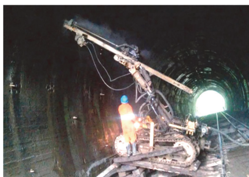
(a) Perfuração dos chumbadores otimizados
