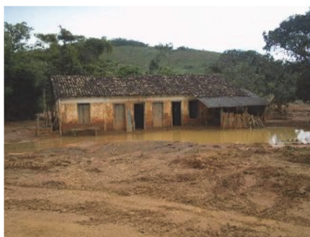
(b) Detalhe das residências atingidas
