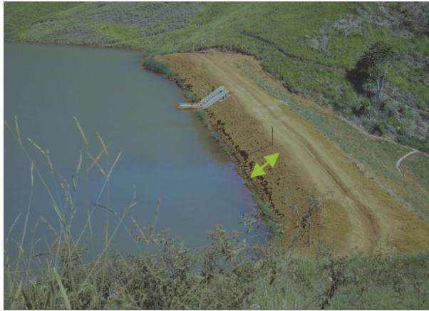
Fig. 15 – Vista do talude de montante da Barragem São Francisco, após o alteamento de 2m (CAOMA, 2006b)
