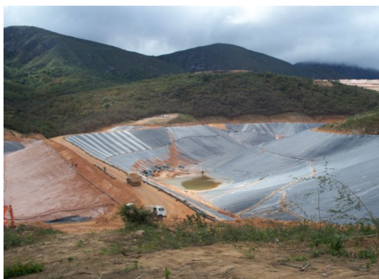
(b) Impermeabilização do reservatório - JYGM.
