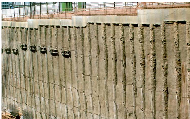
Fig. 14 – Cortina de estacas de betão armado com espaçamento entre eixos superior ao respetivo diâmetro, El Corte Inglés , Lisboa, 1999 (gentileza de Teixeira Duarte, Lisboa).
