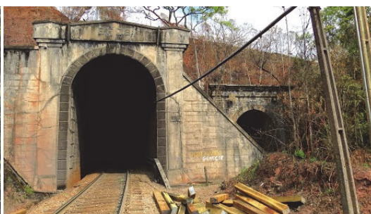
(b) Túneis 25 de 1875 e 1948 em serviço
