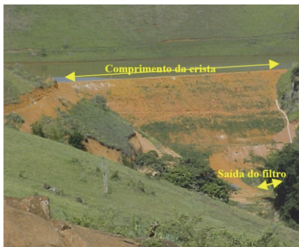
Fig. 16 – Vista do talude de jusante da Barragem São Francisco, após o alteamento (CAOMA, 2006b)
