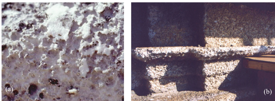
Fig. 7 – (a) Biocolonização em calcários do mosteiro dos Jerónimos; (b) desintegração de um bloco de granito (Delgado Rodrigues, 2007).
