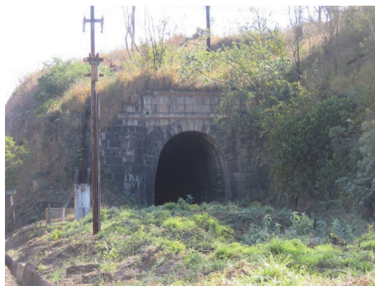
(a) Cobertura reduzida e cicatrizes de ruptura e erosões e depósitos de blocos e solo
