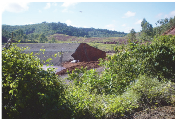
Fig. 9 – Florestal Cataguases. Imagem da seção da Barragem B, após a ruptura.
