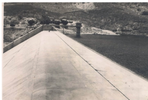
(c) Placas de concreto no sangradouro
