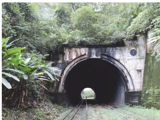
(a) Emboque com espelho assimétrico e muro
