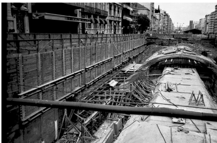
Fig. 9 – Cortina tipo Berlim ancorada, Estação Saldanha, Metropolitano de Lisboa, 1977 (gentileza de Teixeira Duarte, Lisboa).
