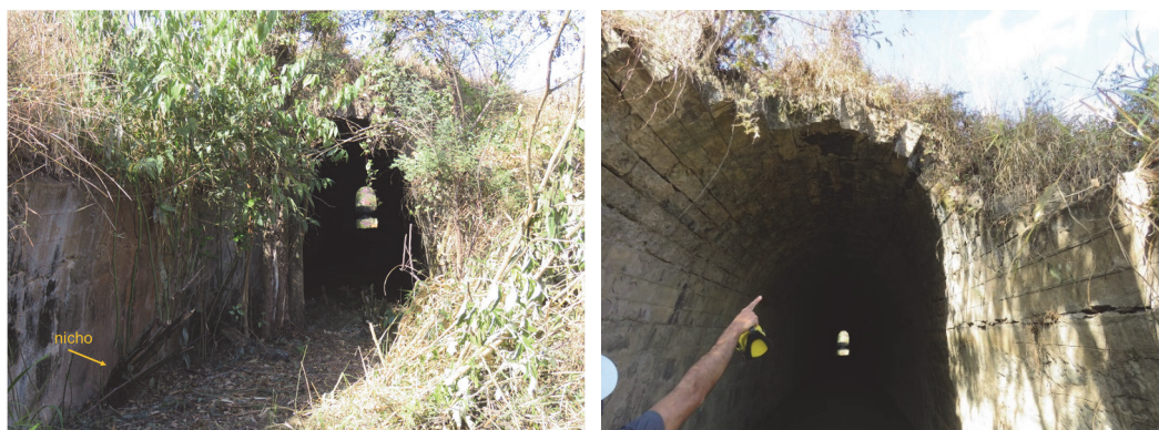
(a) Trinca horizontal aberta e deslocada do eixo na parede e nicho soterrado
