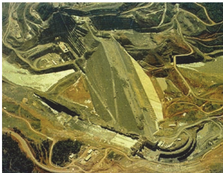
Fig. 9 – UHE Foz do Areia. Face de concreto em construção, com o rio desviado na margem direita.
