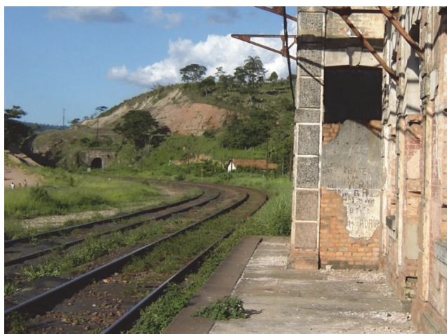
Fig. 8 – Túnel Marinhos visto da estação após corte do maciço para a obra da variante de 2 vias.
