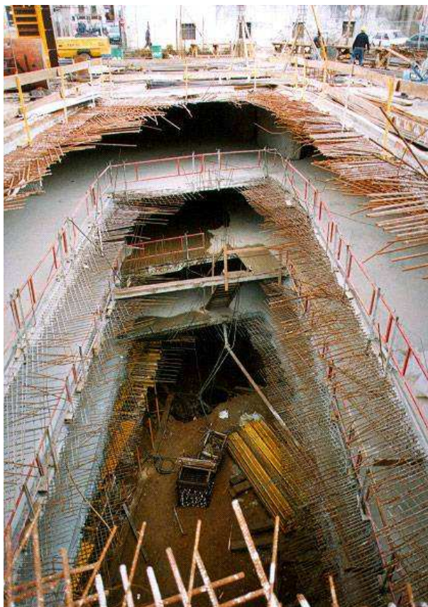
Fig. 8 – Solução top-down , com as lajes da estrutura definitiva parcialmente betonadas, Coimbra, 1998 (gentileza de Teixeira Duarte, Lisboa).
