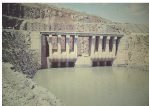
(b) Canal e túneis de desvio em operação, lado montante.
