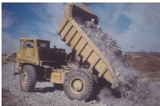
(e) Lançamento do enrocamento na aba jusante
