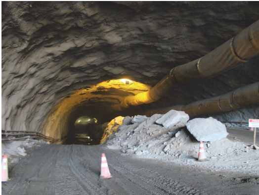
(a) Construção – Março 2011
