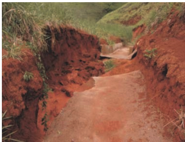
Fig. 22 – Barragem São Francisco. Canal do antigo vertedouro de emergência, erodido pela água em janeiro de 2007
