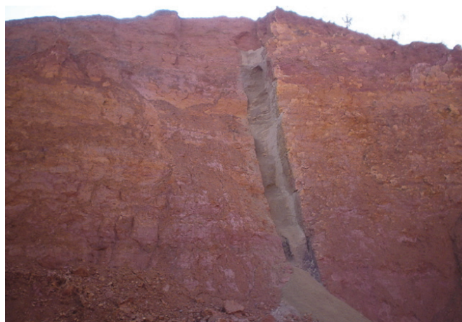
Fig. 10 – Florestal Cataguases. Detalhe da seção da Barragem B, sendo possível notar o solo homogêneo compactado com o filtro chaminé (drenagem interna).
