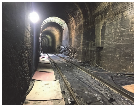
(a) Tela eletrosoldada sistemática na região de rim
